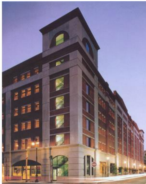
Figur 5-2 Bryan Street parking Garage, Savannah, USA. 497 parkeringsplatser i byggnaden på 22 000 m 2 . Foto: M. B. Kahn Construction.
