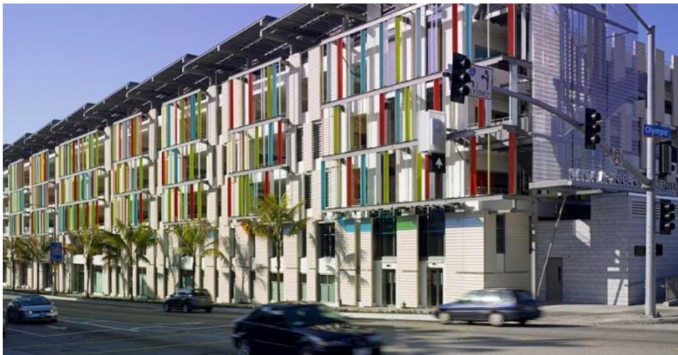
Figur 5-5 SANTA MONICA CIVIC CENTER PARKING STRUCTURE, 28 000 m 2 som rymmer 882 parkeringsplatser i 6 våningar varav två under mark. Foto: John Edward Linden.
