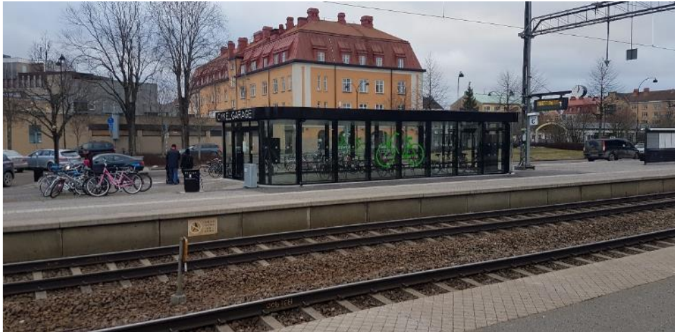
Figur 6-1 Cykelparkeringsgarage vid Katrineholms station. 51
