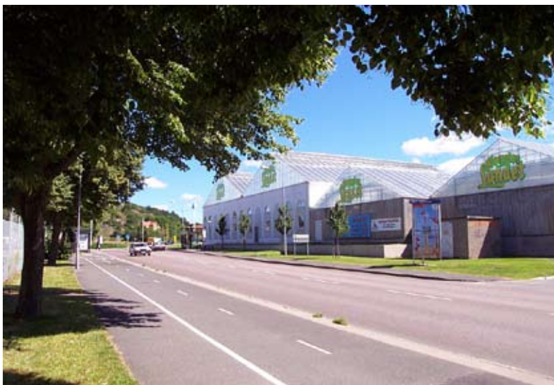
Stora delar av området har idag bebyggelse i en och två våningar
