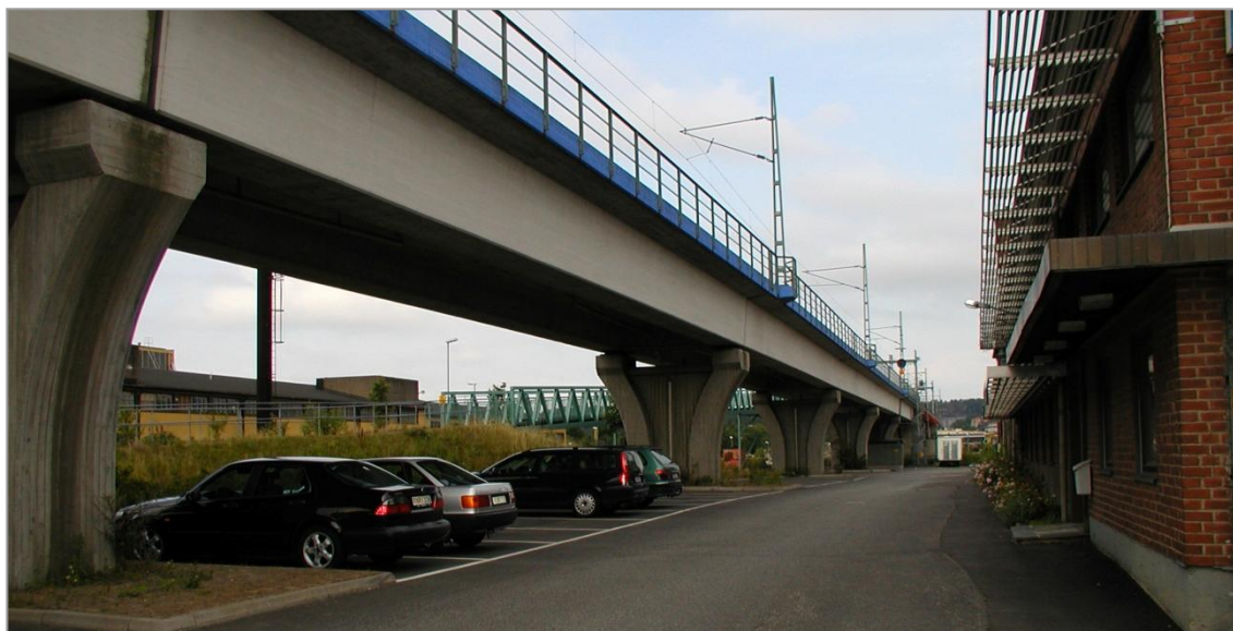
Fastighet utmed Marieholmsgatan som använder mark under Marieholmsbron för parkering.
