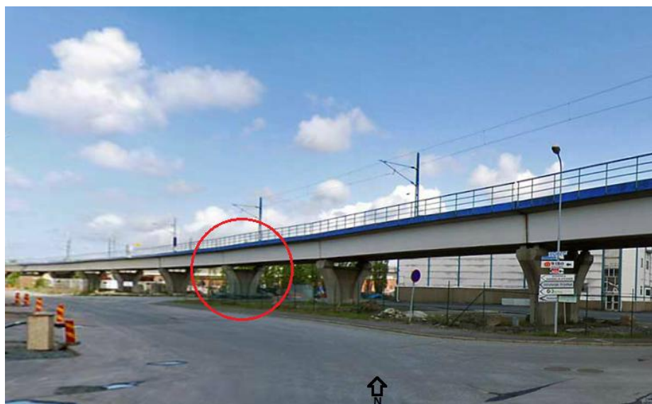
Figur 2. Vid inringad bropelare finns en stuprörsränna som samlar upp dagvatten från järnvägsbron innan vattnet infiltreras i marken. Provtagningspunkten utgjordes av stuprörsrännans utlopp.
