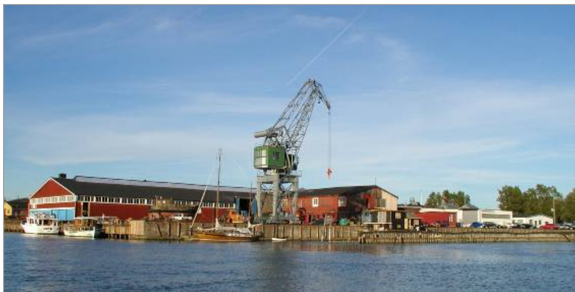
Söder om planområdet bedrivs bl.a. småbåtsverksamhet, dessutom med en karaktärsfull kran.
