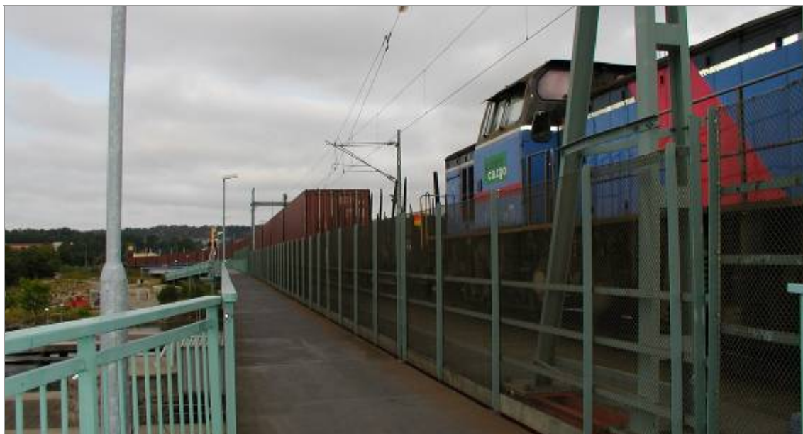
Dagens gc-bana utmed Marieholmsbron har en fri bredd på 2,5 meter för bropassagen.
