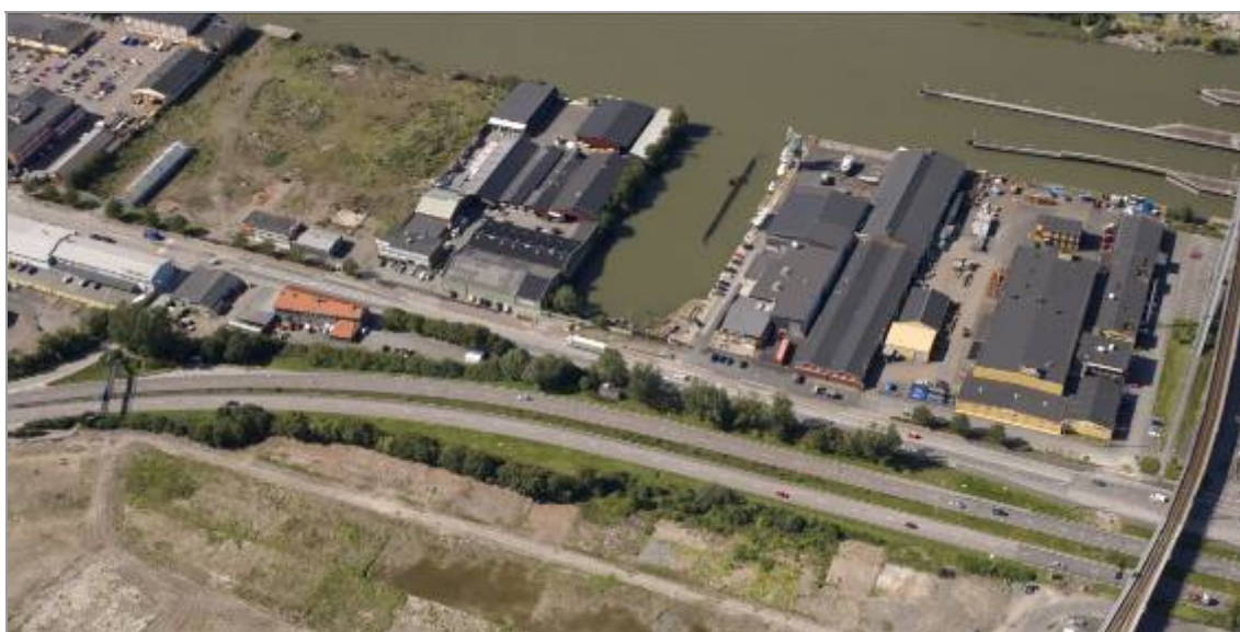
Avrivna ytor öster om E45 där byggandet av Partihallsbron nu pågår. Närmast Marieholmsbron syns de gula byggnader som berörs av järnvägsprojektet och som kommer att rivas.
