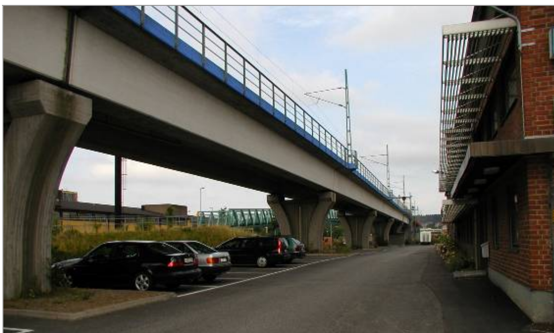
Fastighet utmed Marieholmsgatan som använder mark under Marieholmsbron för parkering.
