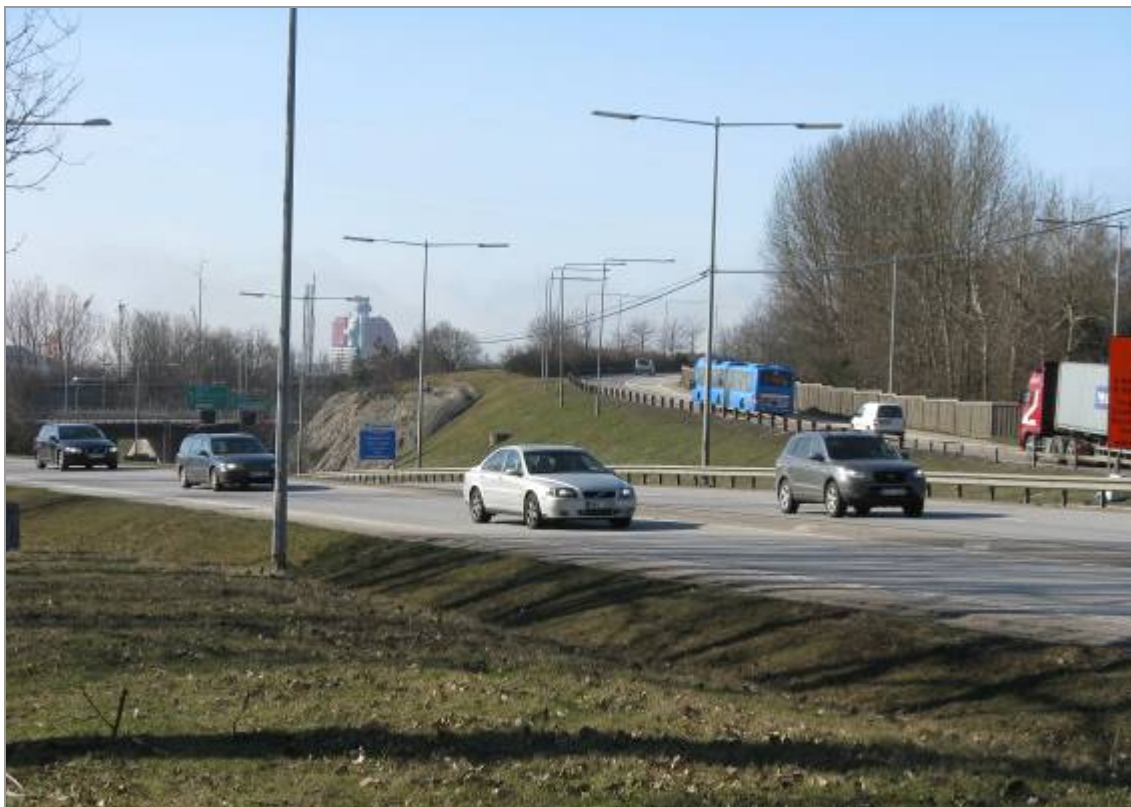
Trafiklandskap inte långt från Göteborgs centrum. Ringömotet idag med anslutningar till Tingstadstunneln och Lundbyleden. Hamn-/Bohusbanan passerar på bro i bakgrunden.
