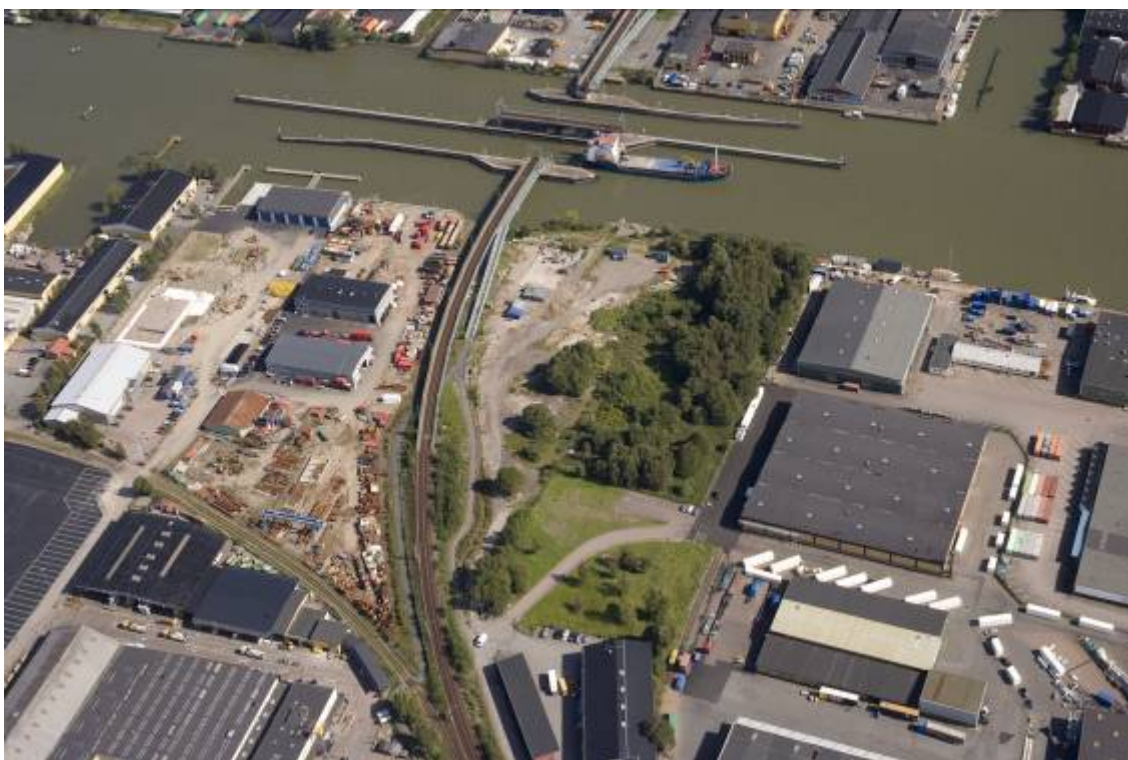
Bebyggelse på ömse sidor om Marieholmsbron sett från väster. Även den obebyggda och idag grönskan-de ytan söder om bron har tidigare haft verksamheter och marken är påverkad av industrianvändningen.
