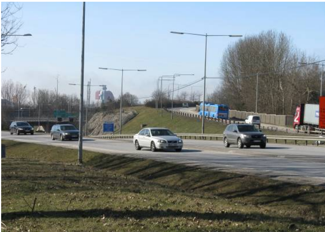
Trafiklandskap inte långt från Göteborgs centrum. Ringömotet idag med anslutningar till Tingstadstunneln och Lundbyleden. Hamn-/Bohusbanan passerar på bro.
