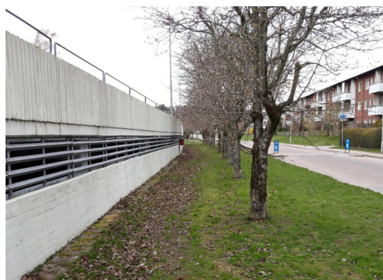
Figur 9. Oxelallé med en del intressanta lavararter i delområde 8.
