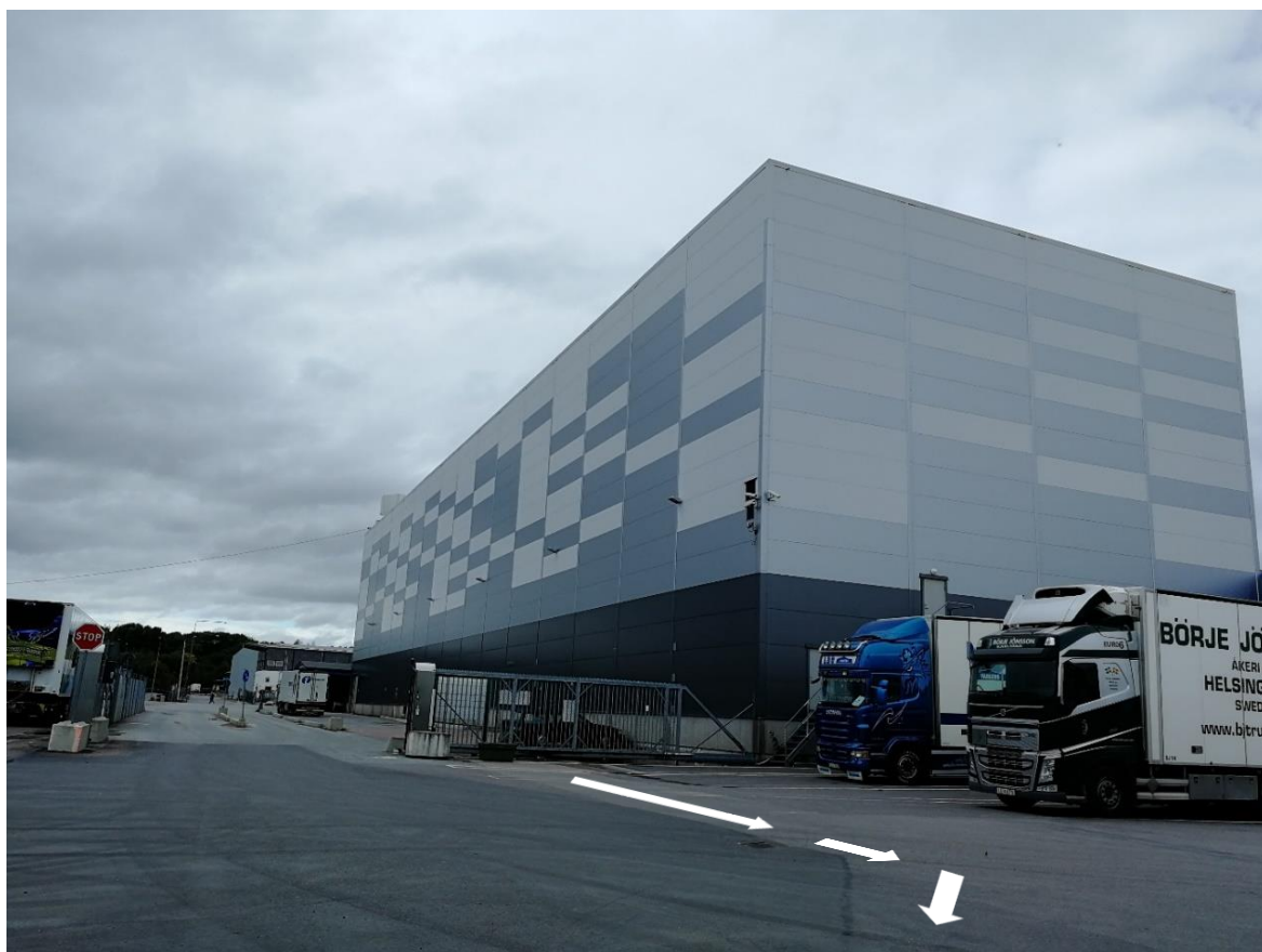
Figur 21. Platsbesök, bild 1. Utredningsområdets norra delområde, taget från sydost. Pilar visar flödesriktning. Foto: Kristin Holmberg
