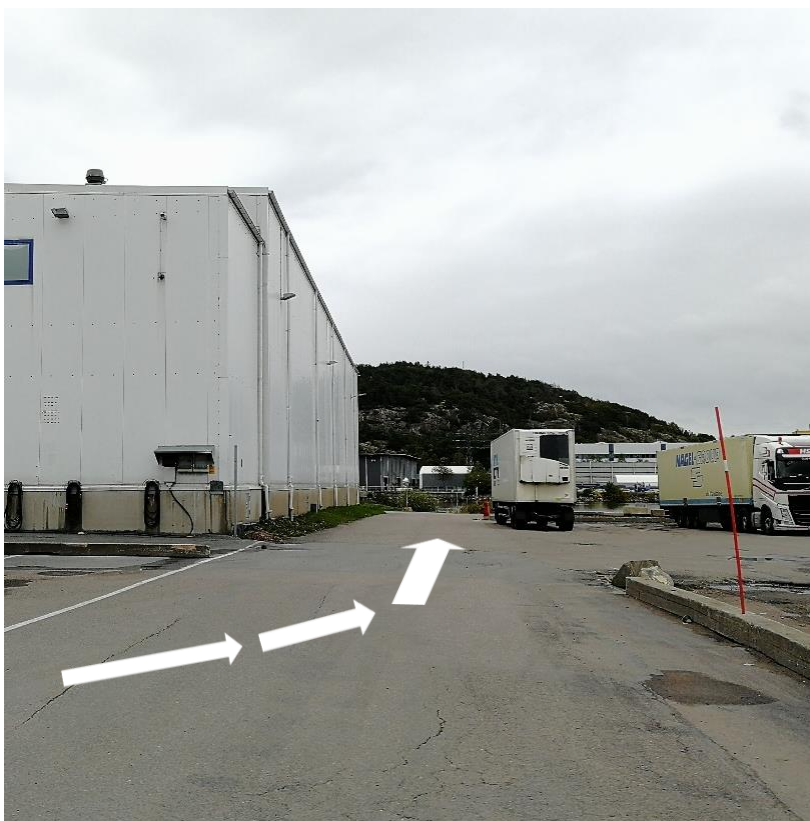
Figur 26. Platsbesök, bild 2. Nordöstra delen av utredningsområdet södra delområde, taget från väst. Pilar visar flödesriktning. Foto: Kristin Holmberg
