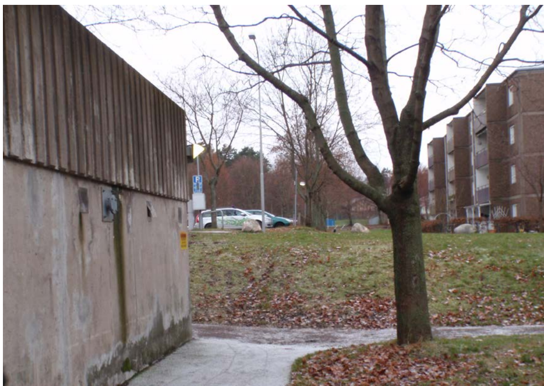
Befintligt p-däck med skyddsrum
