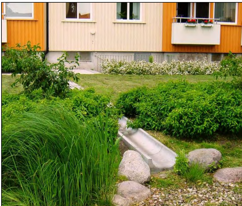
Figur 6. Exempel på ränna för avledning av takvatten
