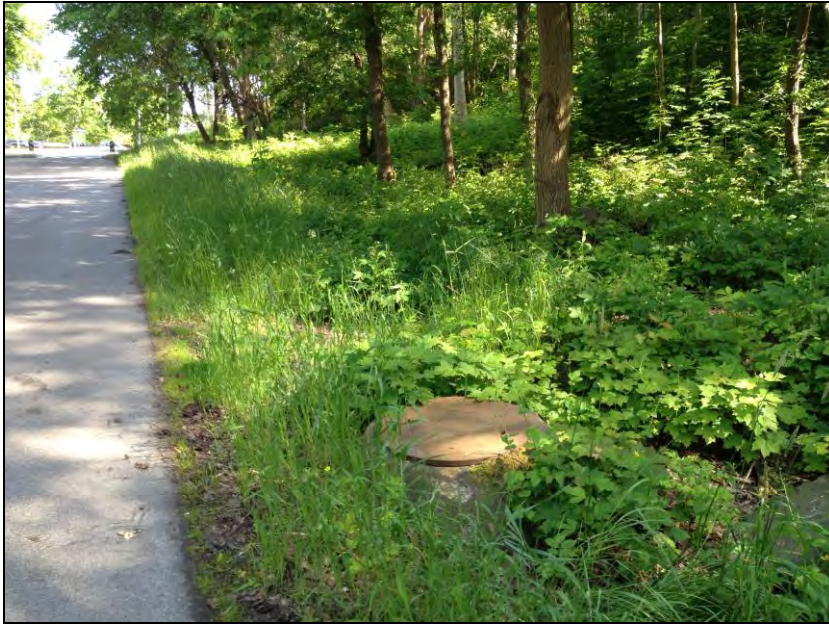
Figur 2. Del av Wadköpingsgatan, intilliggande naturmark samt brunn tillhörande system för avvattning av Wadköpingsgatan och naturmarken
