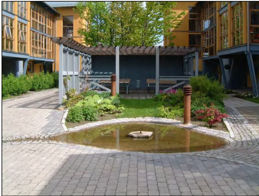
Figur 7. Exempel på yttlig magasinering av dagvatten
