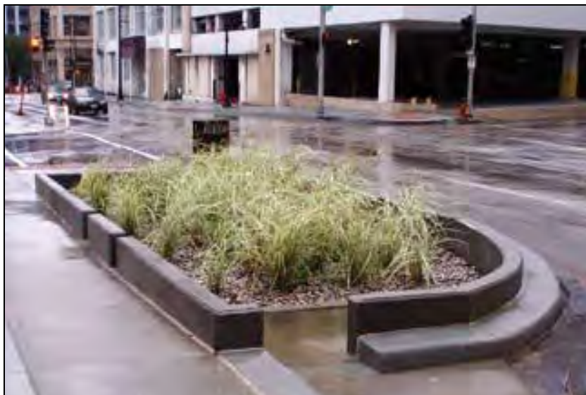
Figur 17. Exempel på Rain garden längs en väg, observera utformning av kantsten (Källa: VegTech)
