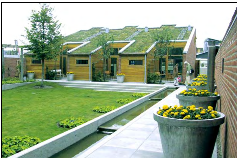
Figur 12. Byggnad med grönt tak. Källa: Vegtech
