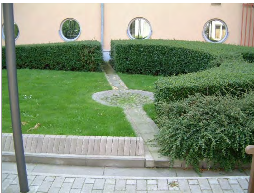
Figur 5. Exempel på ränna för avledning av takvatten
