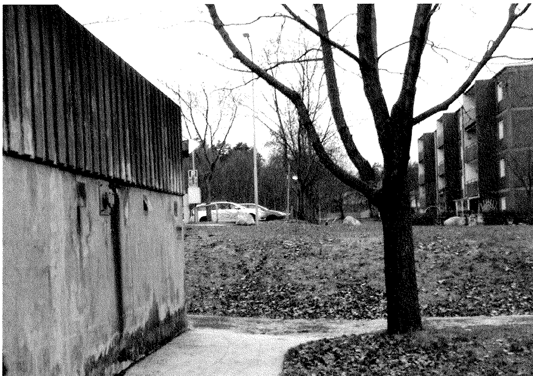
Befintligt p-däck med skyddsrum
