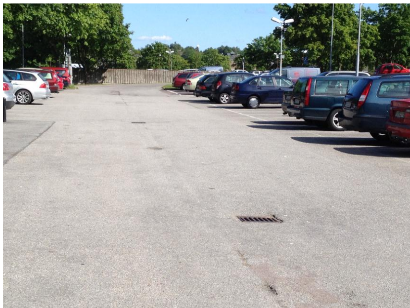
Figur 3. Befintlig parkeringsyta med rännstensbrunnar mellan Katjas gata och Julias gata
