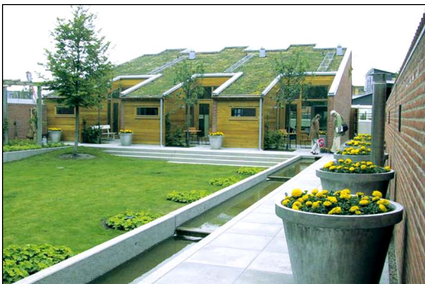
Figur 12. Byggnad med grönt tak. Källa: Vegtech
