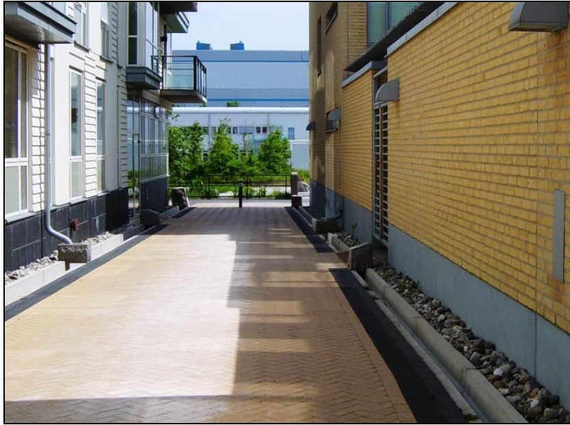
Figur 4. Stuprören ansluter till rännor för avledning av takvatten
