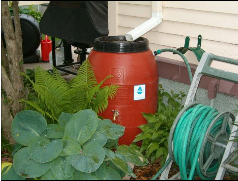
Figur 16. Regnvattentunna för magasinering av dagvatten
