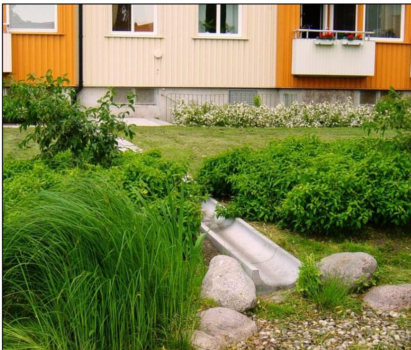
Figur 6. Exempel på ränna för avledning av takvatten
