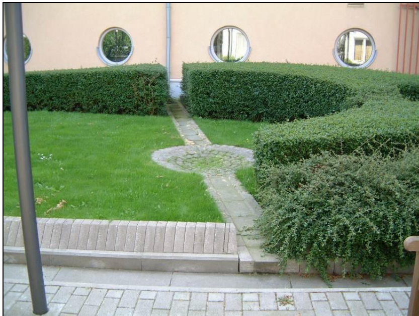
Figur 5. Exempel på ränna för avledning av takvatten
