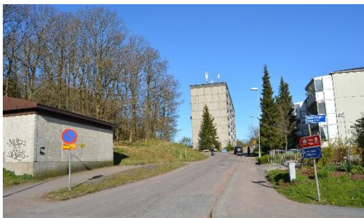
Krumeluren i anslutning mot befintlig bebyggelse.
