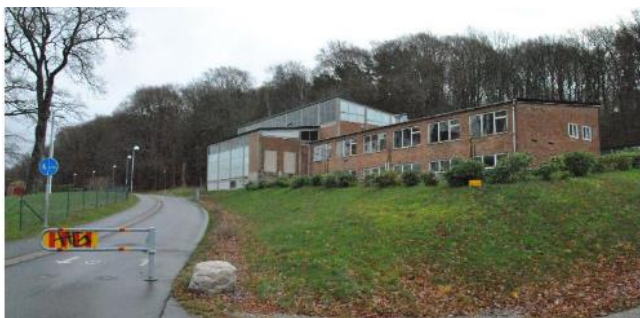
Figur 18 Byggnad nummer 12 (maskinbyggnad/panncentral) samt tillhörande verkstadsdel (nu rivet). Foto: SBK, 2014
