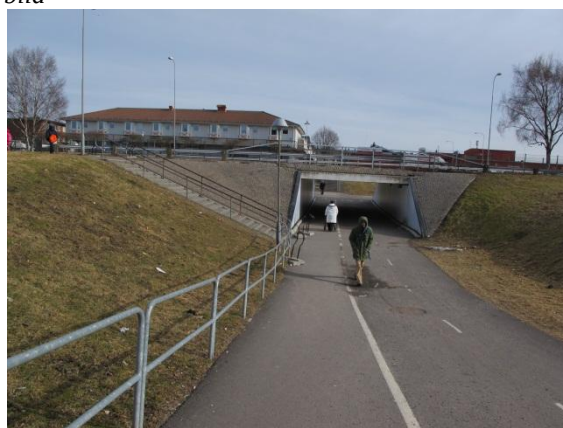
Gångtunneln under Litteraturgatan tas bort
