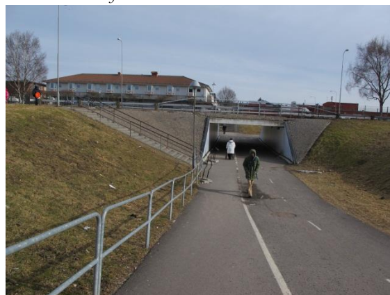
Gångtunnel under Litteraturgatan tas bort.
