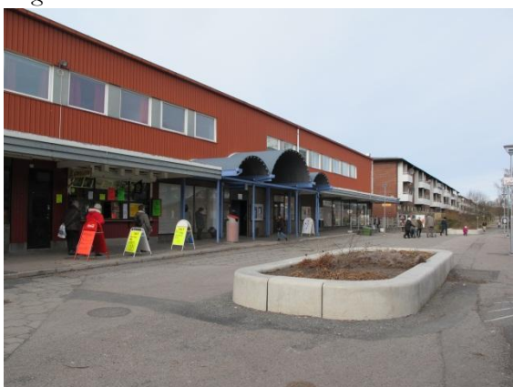
Centrumbyggnad med ingång till kulturhus.
