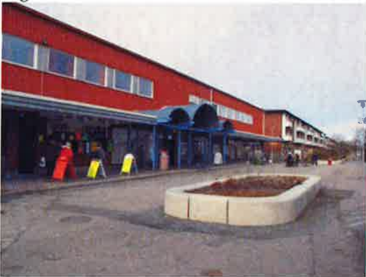
Centrumbyggnad med ingång till kulturhus
