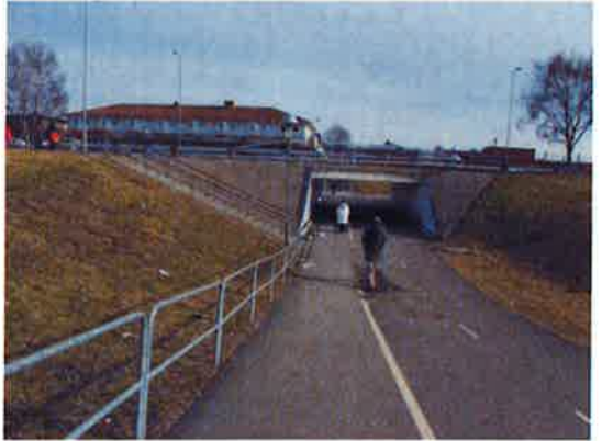
Gångtunneln under Litteraturgatan tas bort
