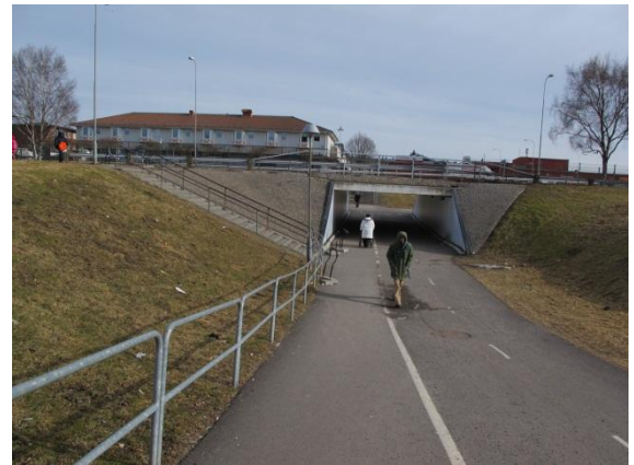
Gångtunneln under Litteraturgatan tas bort
