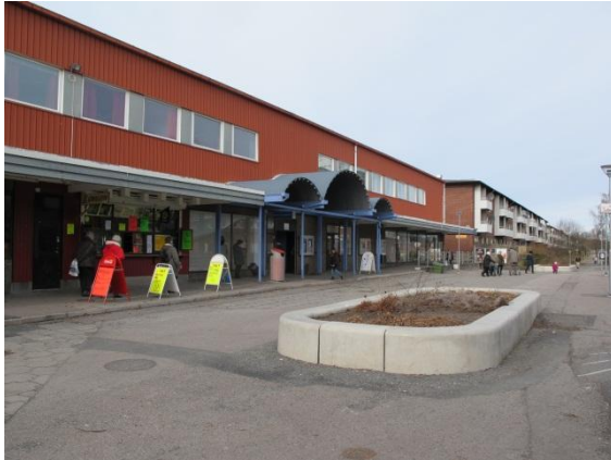
Centrumbyggnad med ingång till kulturhus
