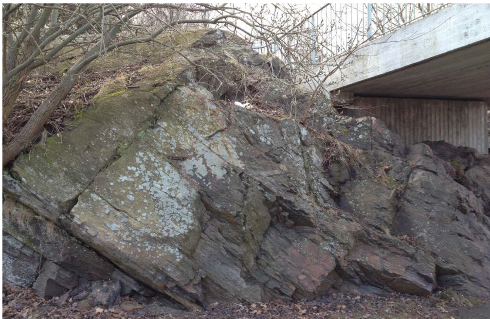
Foto 2. Rådande spricksystem åt väster och söder
