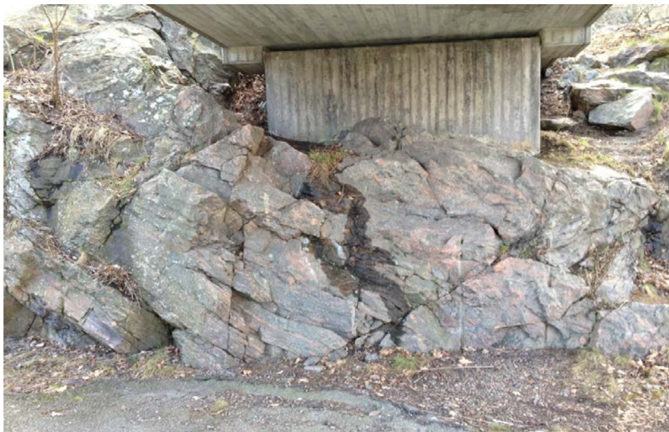
Foto 1. Uppsprucket berg vid brofästet
