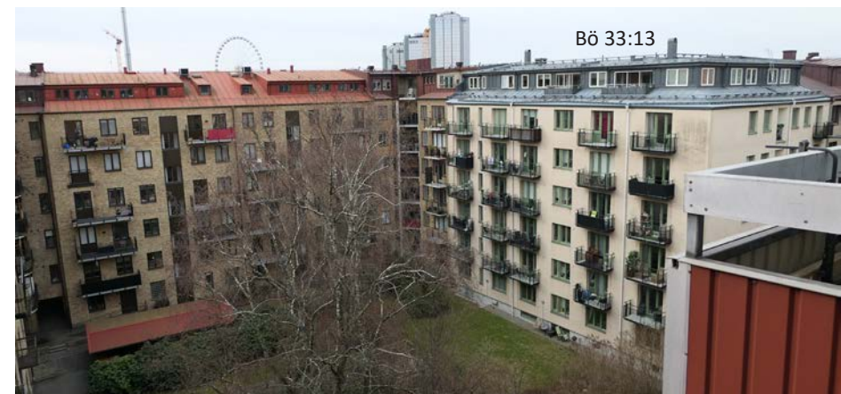
Kvarteret Skålsnäckan, gårdsfasader mot väst. Här förekommer såväl takkupor som taklyft. Taklyftet på Bö 33:13 är väl anpassat till byggnadens modernistiska karaktär. Till skillnad från fasaderna mot öst har taklyftet dragits in från takfoten.
