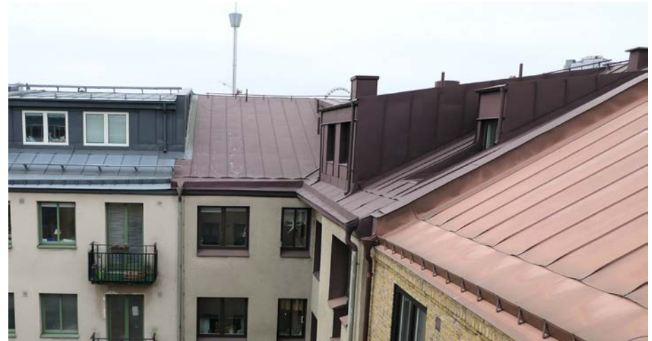
Ursprunglig plåtinklädd takkupa mot tvättstuga på Bö 33:14.
