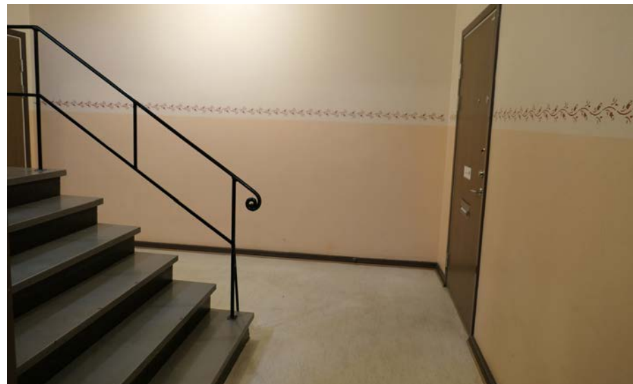
Trapphus med ursprunglig kalkstenstrappa och smidesräcke.
