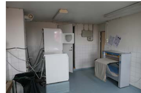
Tvättstuga på vind.
