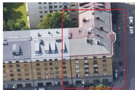
Takfall mot gatan är belagt med skiffer.
