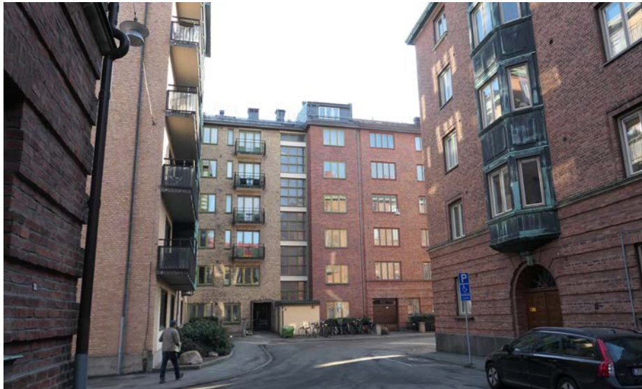
Kvarteret Skålsnäckan, från kvarteret Valthornssnäckans gård framträder taklandskapet i gatubilden.
