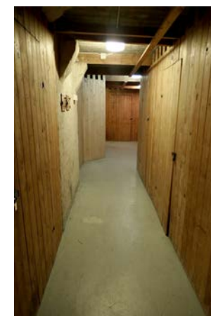
Välbevarad vind med ursprungliga vindsförråd.
