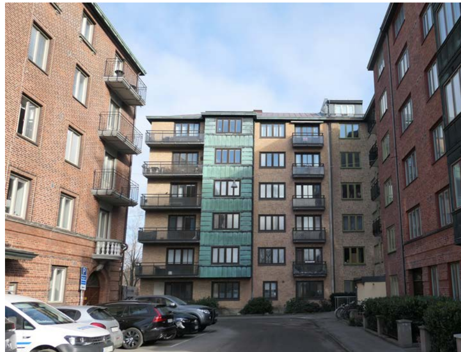
Kvarteret Skålnäcken, från Påskbergsgatan med Påskbergsgatan 6 i fonden. Hörnhusets taklandskap är exponerat i gatubilden.
