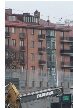
Fasad mot Påskbergsgatan från håll. Här framträder taklandskapet tydligt.
