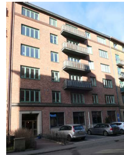
Fasad mot Jättegrytsgatan med stram utformning.
