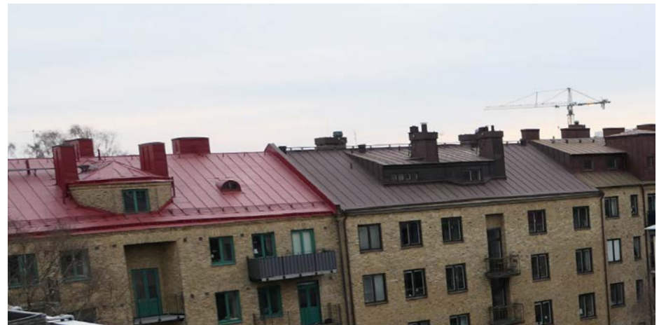
Ursprungliga takkupor i kvarterets södra sida. Fastigheten Bö 33:7 bevarar sin tegelmurade kupa mot trapphuset samt två små lunettformade kupor mot vinden. Även fastigheterna Bö 33:8 och 33:9 till höger i bild har ursprungliga plåttäckta kupor mot trapphus/tvättstuga.
