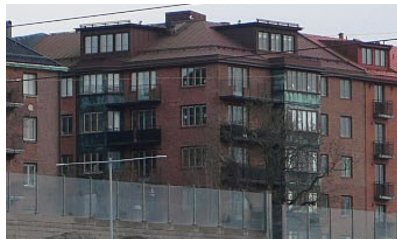
Gatufasad från håll. Takfall mot gatan har försetts med stora takkupor under senare tid.
