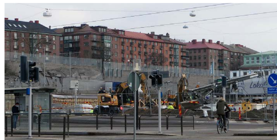
Kvarteret Skålsnäckan sett från Örgrytevägen. I såväl takfall mot väst som norr har nya takkupor tillkommit.
