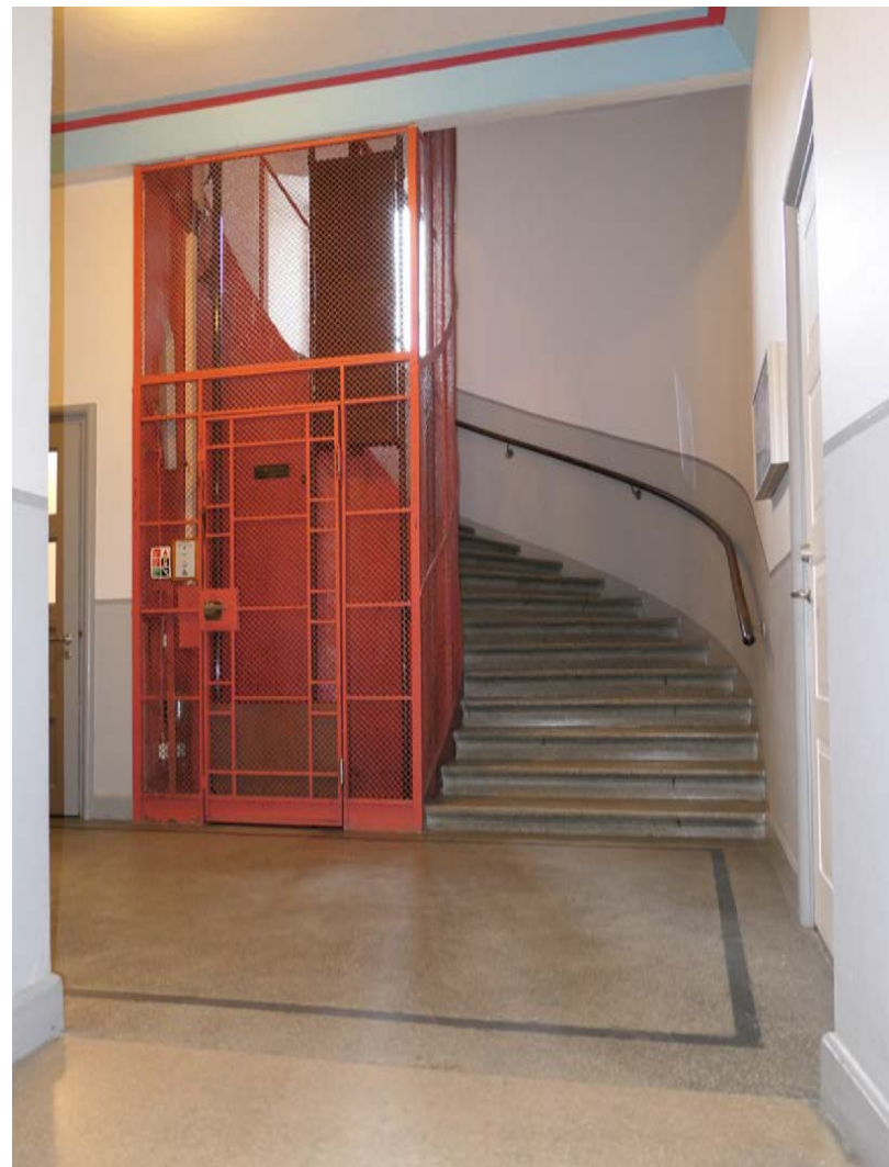
Trapphusen försågs ursprungligen med hiss. Hissarna är placerade ett halvplan upp från entréplanet och har generellt små mått.
