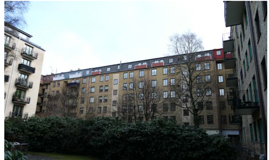
Kvarteret Skålsnäckan, gårdsfasader mot öst där taklyft utförts på samtliga byggnader. Kulör på takplåten varierar, liksom utförandet av terrasserna vilket ger ett brokigt uttryck.
