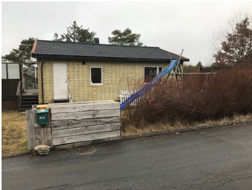
Befintligt bostadshus inom planområdet som avses rivas i samband med genomförandet av detaljplanen.
