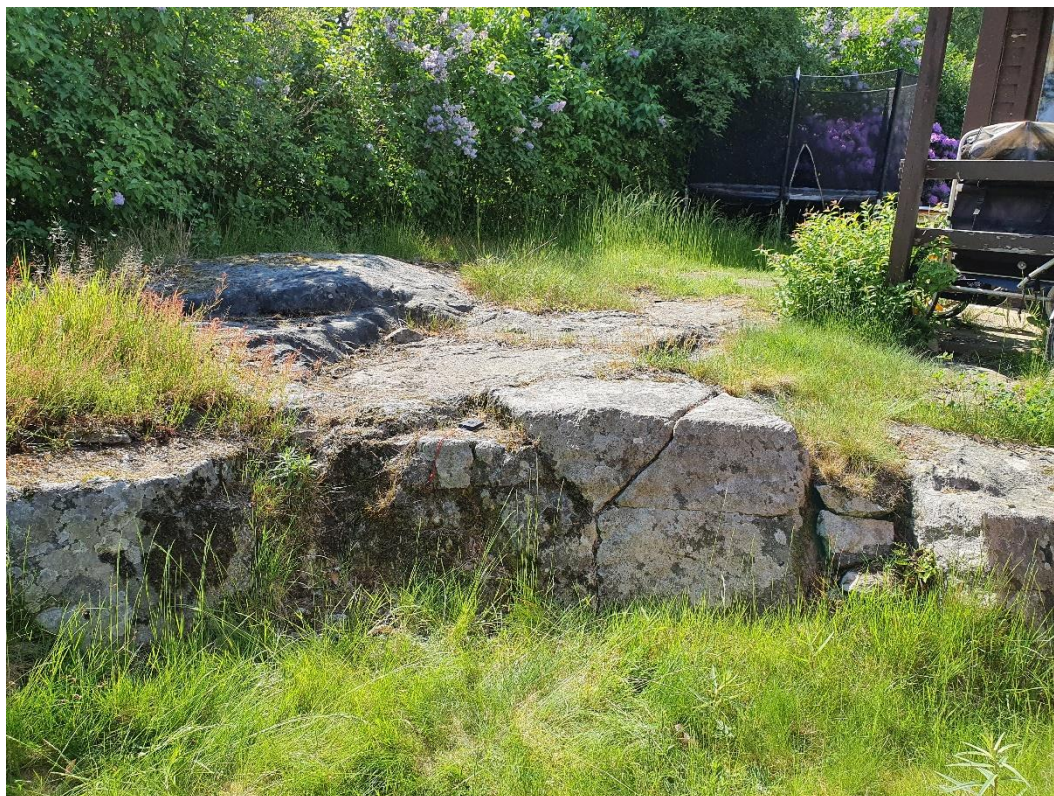
Figur 3.1.1. Blottat berg intill befintlig byggnad. Lavtäckt granit med typisk kubisk uppsprickning och enstaka medelbranta sprickor.
