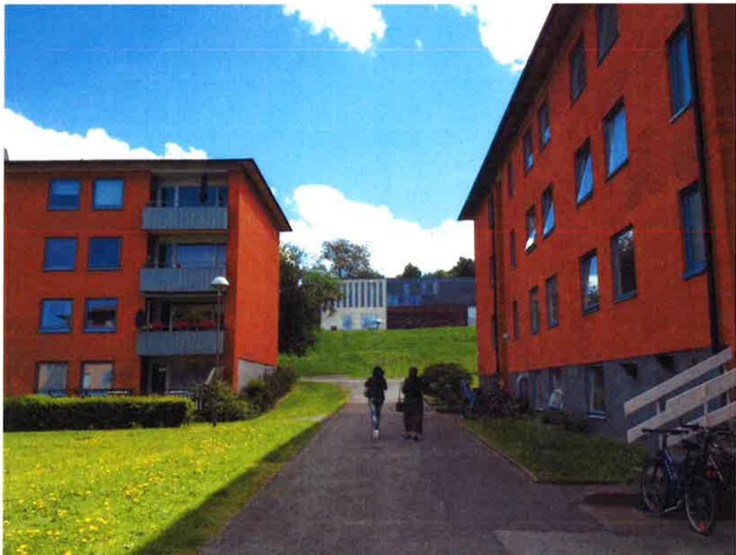
Pilegården, med utsikt mot Panncentralen.
