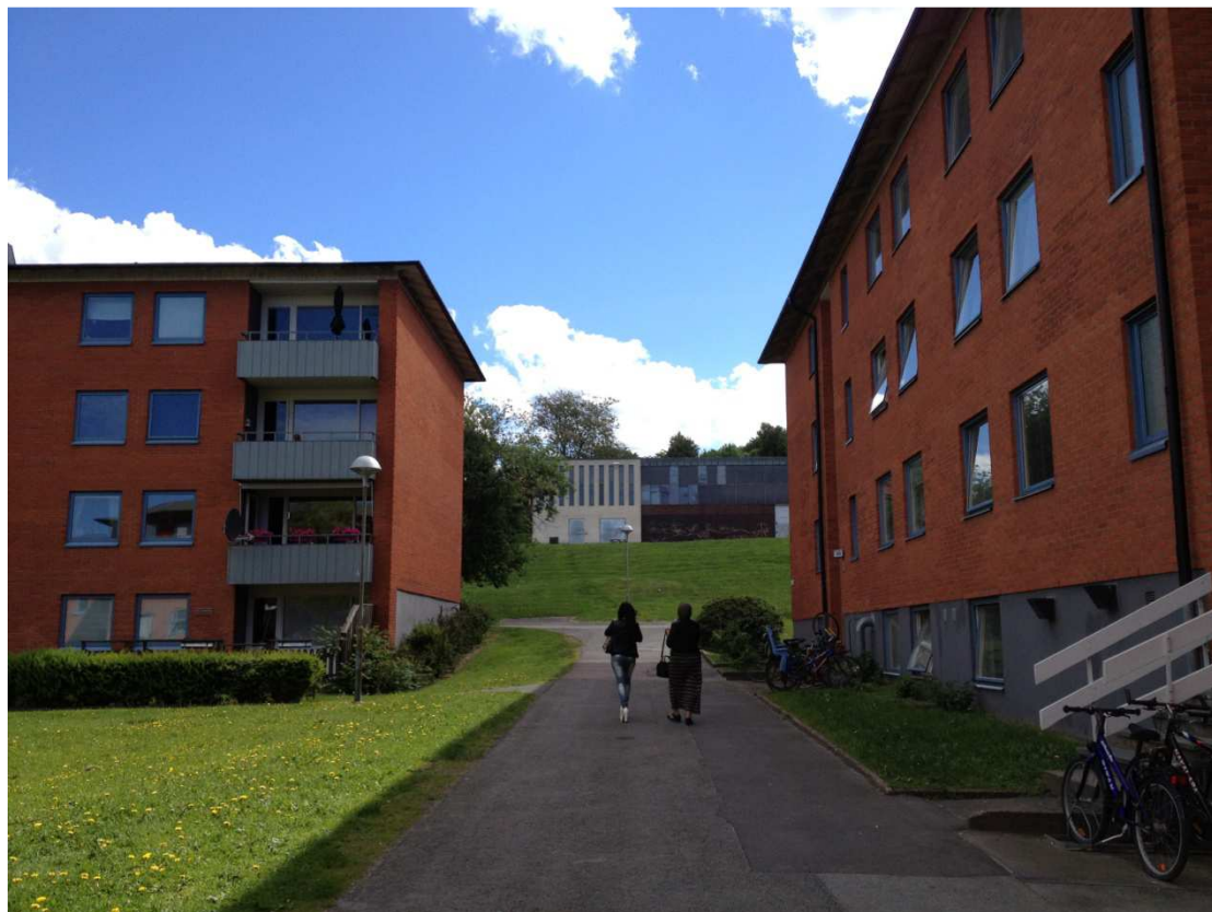
Pilegården, med utsikt mot Panncentralen.
