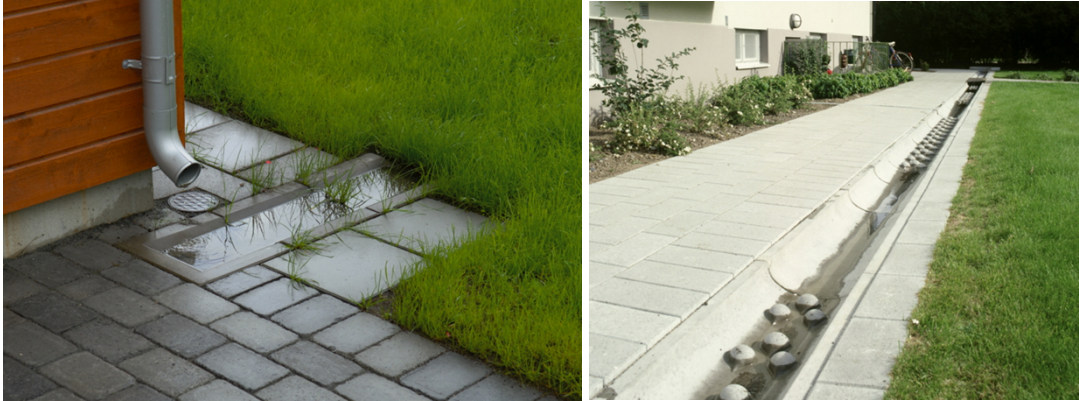
Figur 7: Öppna vattenutkastare och dagvattenrännor. Källa: Steriks.se
