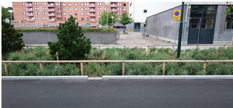
Figur 6: Nedsänkt växtbädd med inlopp genom nedsänkt kantsten.
