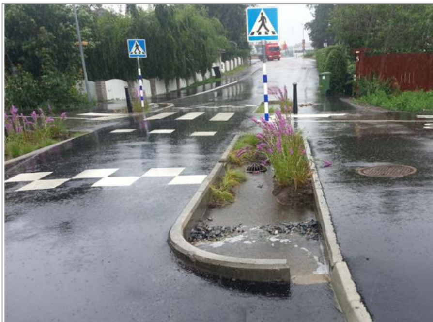
Figur 22. Exempel på biofilter i gatumiljö (Svenskt Vatten 2016)
