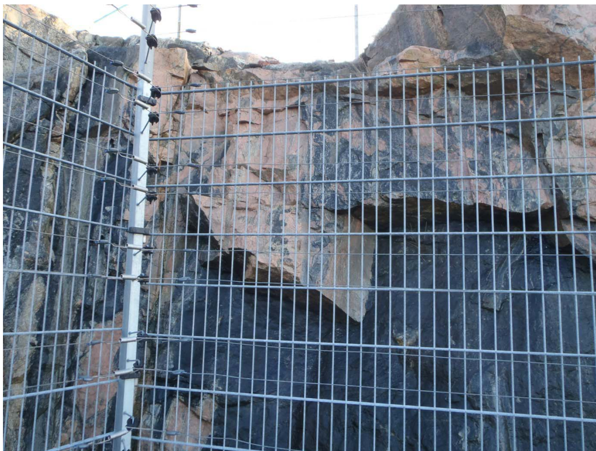
Foto 14. Ett instabilt block i "hörnet" alldeles norr om anslutningsvägen mellan hamnarna (sydöstra hörnet av område 1).
