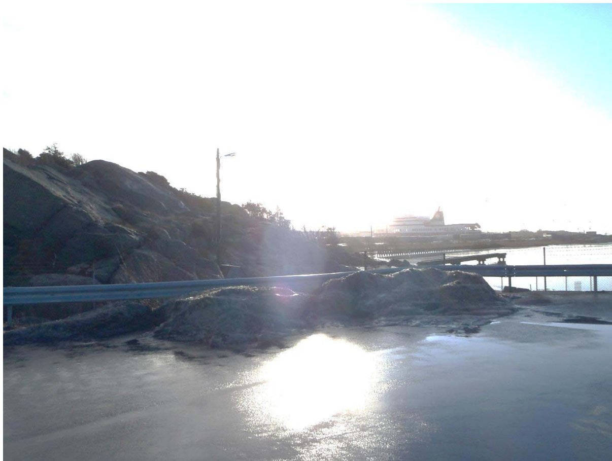
Foto 17. Det mindre bergspartiet söder om anslutningsvägen består av lägre hållar och planeras plansprängas. Hamnbassängen, till höger i bild, planeras fyllas ut.
