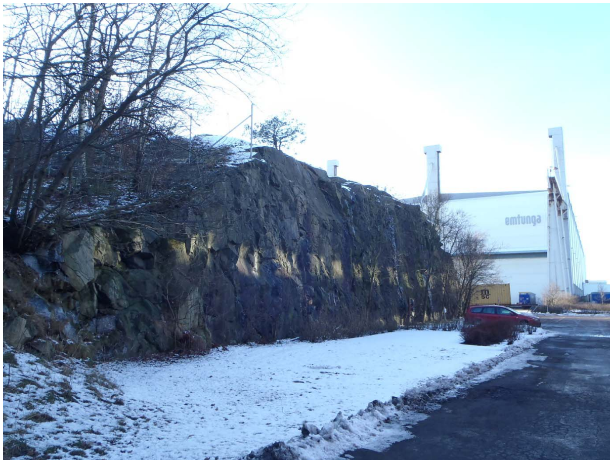
Foto 5. Den höga norra skärningen, bakom bygganden (område 2 på Bilaga 2). Skärningen är ca 10 m hög.
