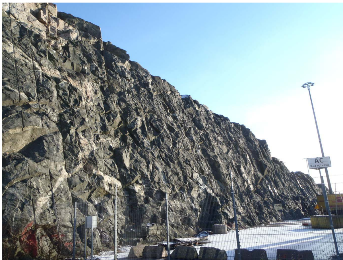
Foto 11. Den västra skärningen fortsätter söderut (område 1). Den mörka basiska bergarten genomslås av ljusare material, vilket syns i det övre vänstra hörnet av bilden.
