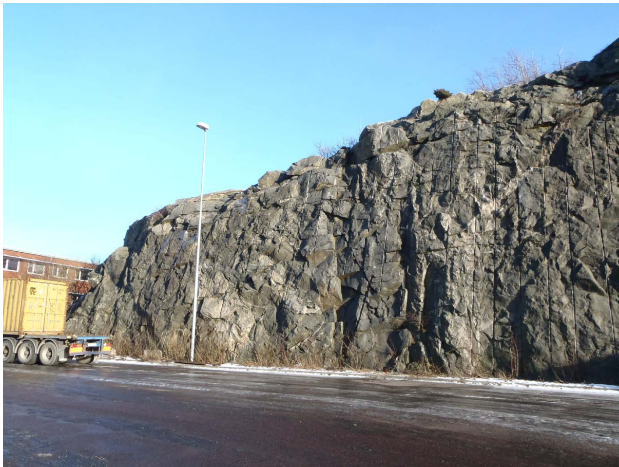
Foto 8. Den norra änden av den västra skärningen (område 1 på Bilaga 2). Skärningen är 15-20 m hög.
