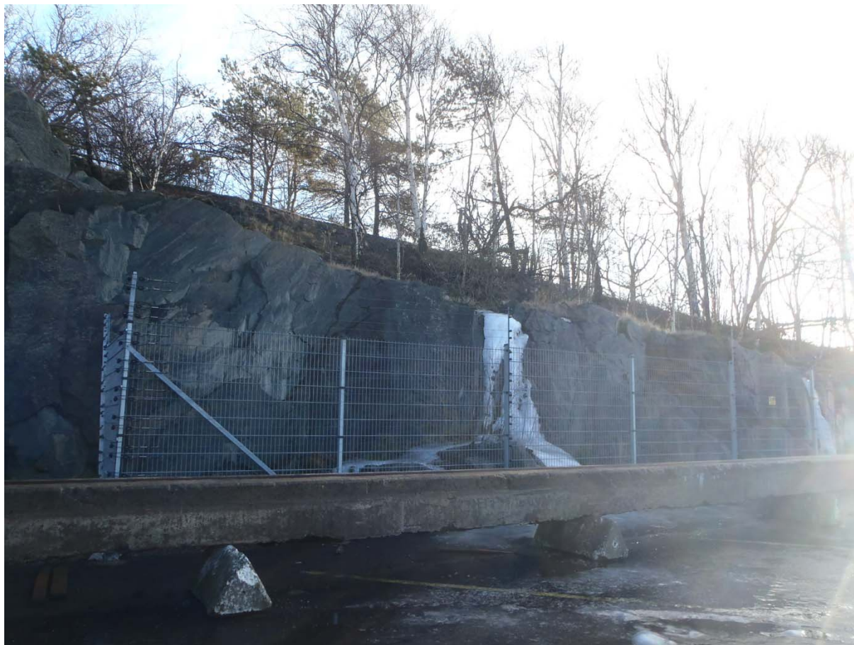
Foto 13. I sydväst är skärningen lägre, med plana, släta sprickytor (område 1).
