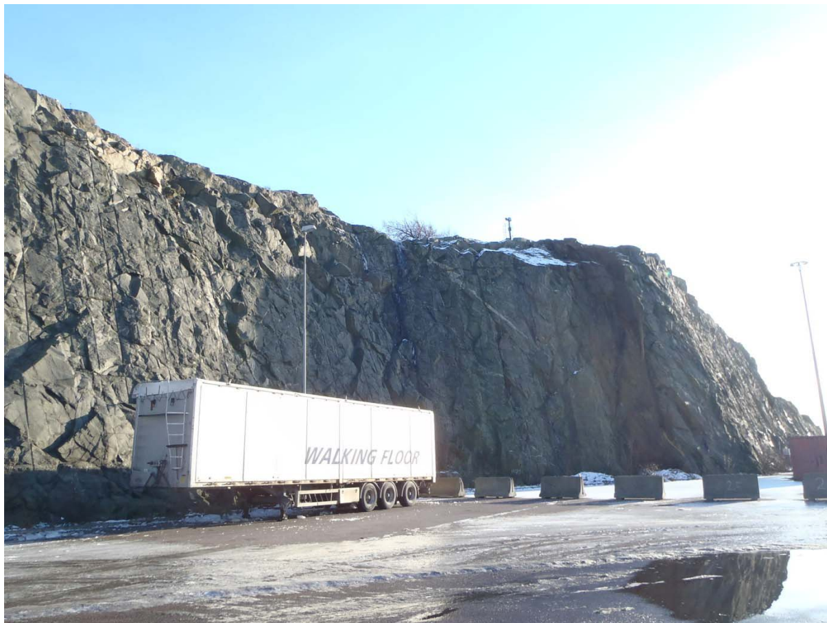
Foto 10. Den västra skärningen fortsätter söderut (område 1). Den bruna remsan i högra delen av bilden är en våd starkt rostat bergnät.
