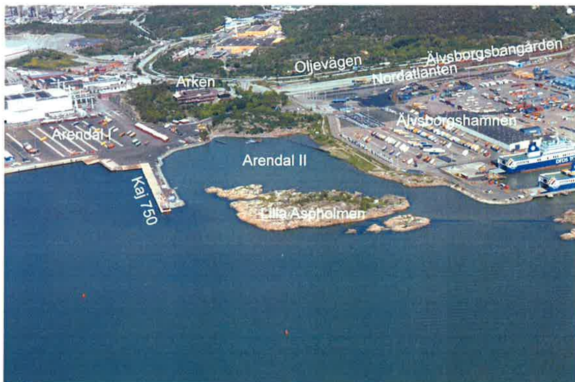
Översikt över hamnar, vägar och järnväg, vy från söder.
