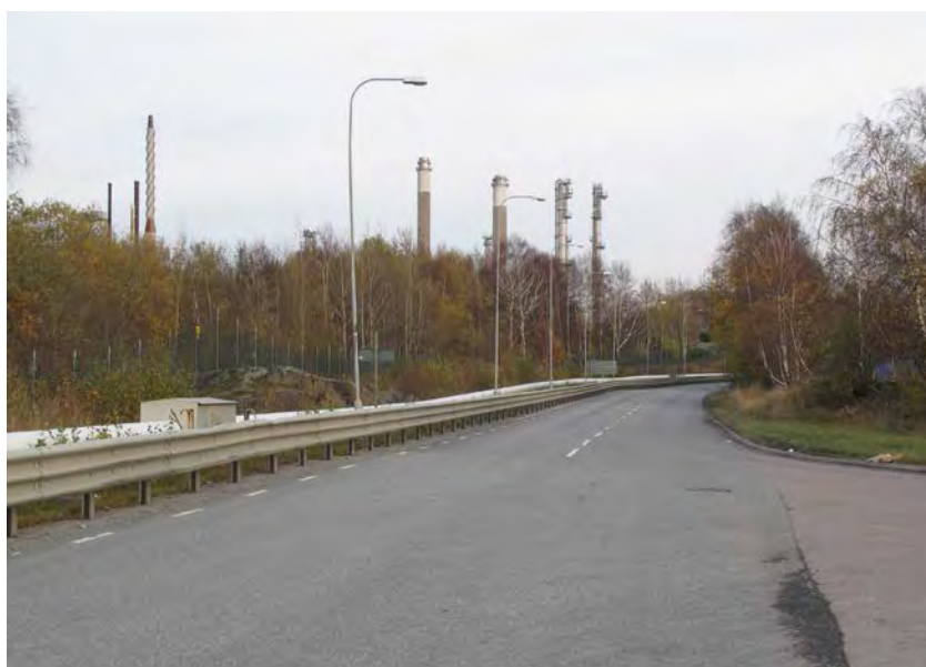
Det finns ett skydd mellan oljeledningarna och Hjärtholmsvägen på vissa sträckor
