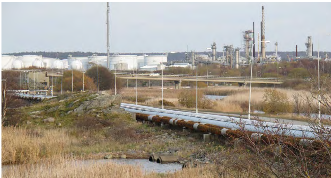
Preem raffinaderi sett från Hjärtholmsvägen. I förgrunden syns råoljeledningarna från Torshamnen till de båda raffinaderierna. Väg och ledningar är förlagda på smala landtungor mellan de olika dammarna.
