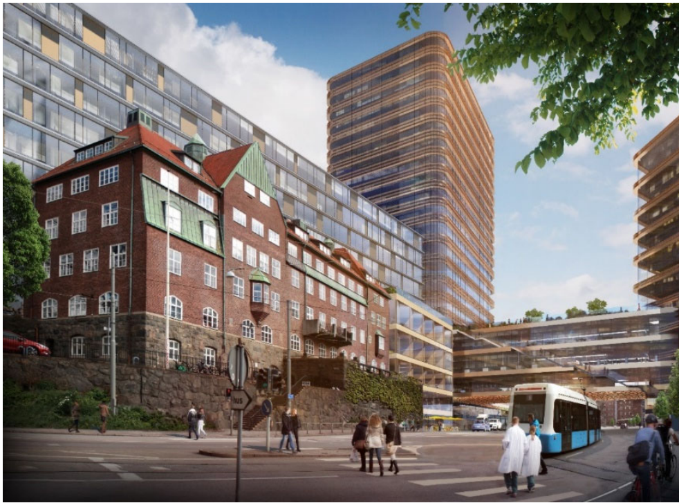
Figur 13. Den äldsta delen av gamla vanförestalten bevaras. Bild: Arkitema/Sweco
