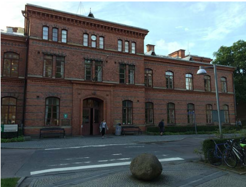
Figur 3 ”Per Dubbhusets” norra fasad fotograferat av Sweco.
