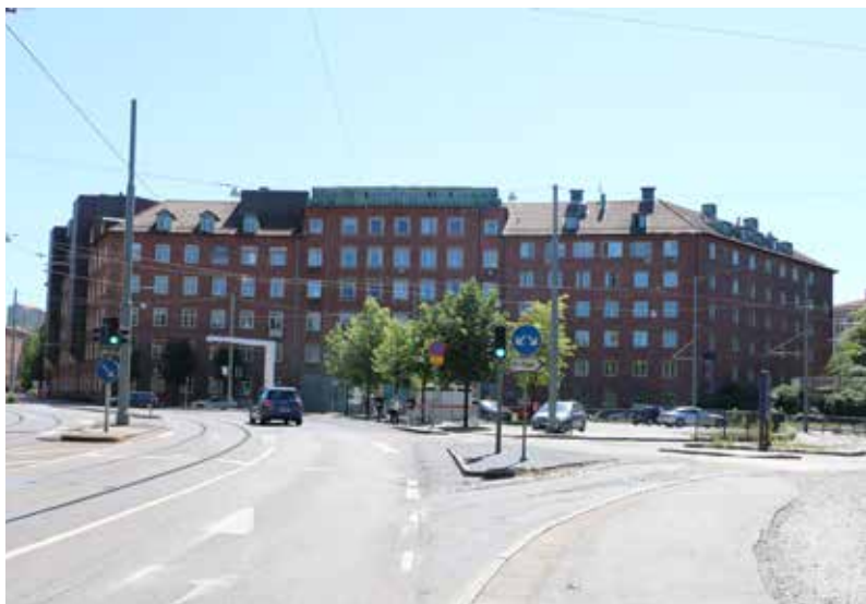
Norra Entrébyggnaden med sin breda och lätt konkava form markerar den norra och ursprungliga ingången till Sahlgrenska sjukhusområde.
