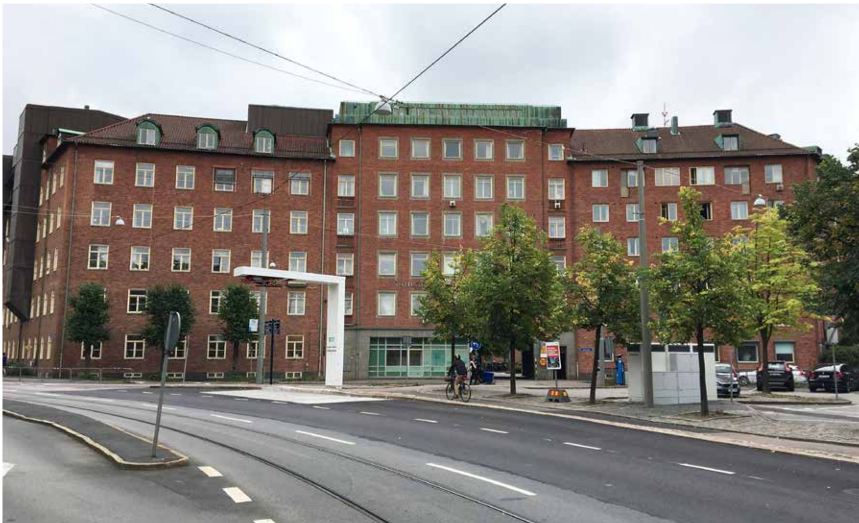
Byggnaden i bild markerar den norra och ursprungliga ingången till Sahlgrenska sjukhusområde. Den senare tillbyggnaden, det som idag utgör norra entrébyggnaden, utformades dock med en centralt placerad portal vilket gjorde att siktlinjen mot Per Dubbshuset bibehölls.
