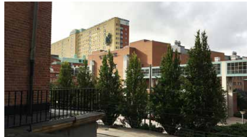
Karaktärsitisk öppning med utblick över sjukhusområdet. Sjukhusets tegelbyggnader utgör ett kollage av geometriska former.
