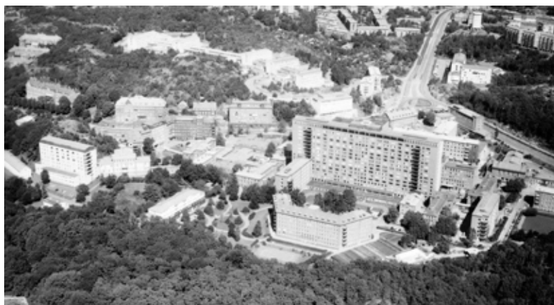
Flygbild över sjukhusområdet år 1962. Byggnationen av det nya central-komplexets skivhus i 18 våningar pågår. Vy mot norr. (Digitalt museum)
