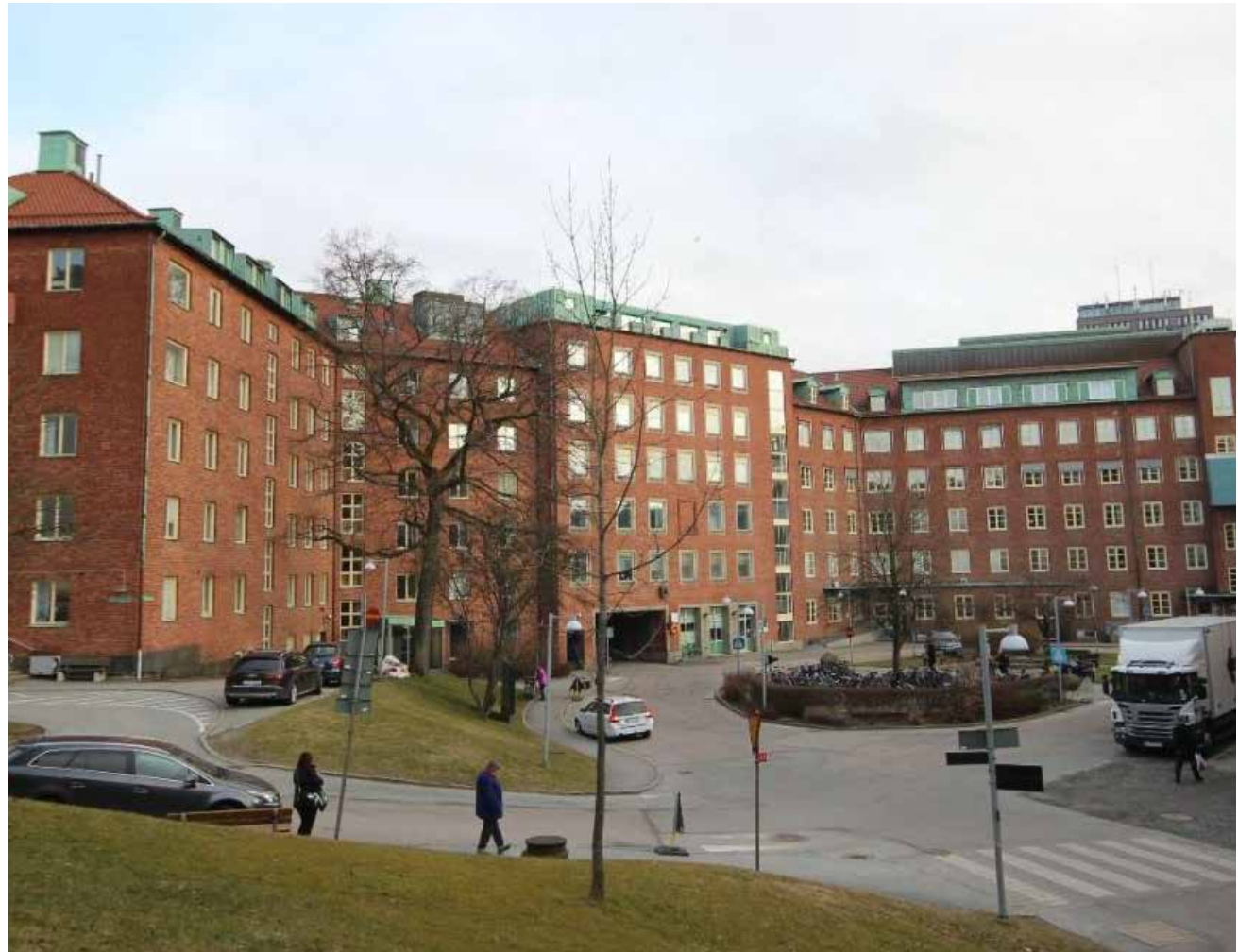
Norra entrébyggnaden sett från sydöst.
