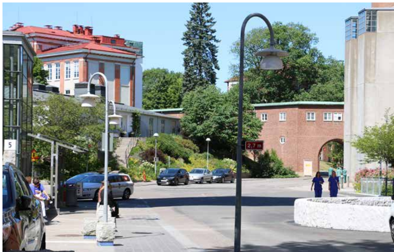
VY 1, Bruna stråket på söder sida om huvudbyggnaden. Här med fokus på den klassicistiska f.d. isoleringspaviljongen och dess länkbyggnad i tegel.
