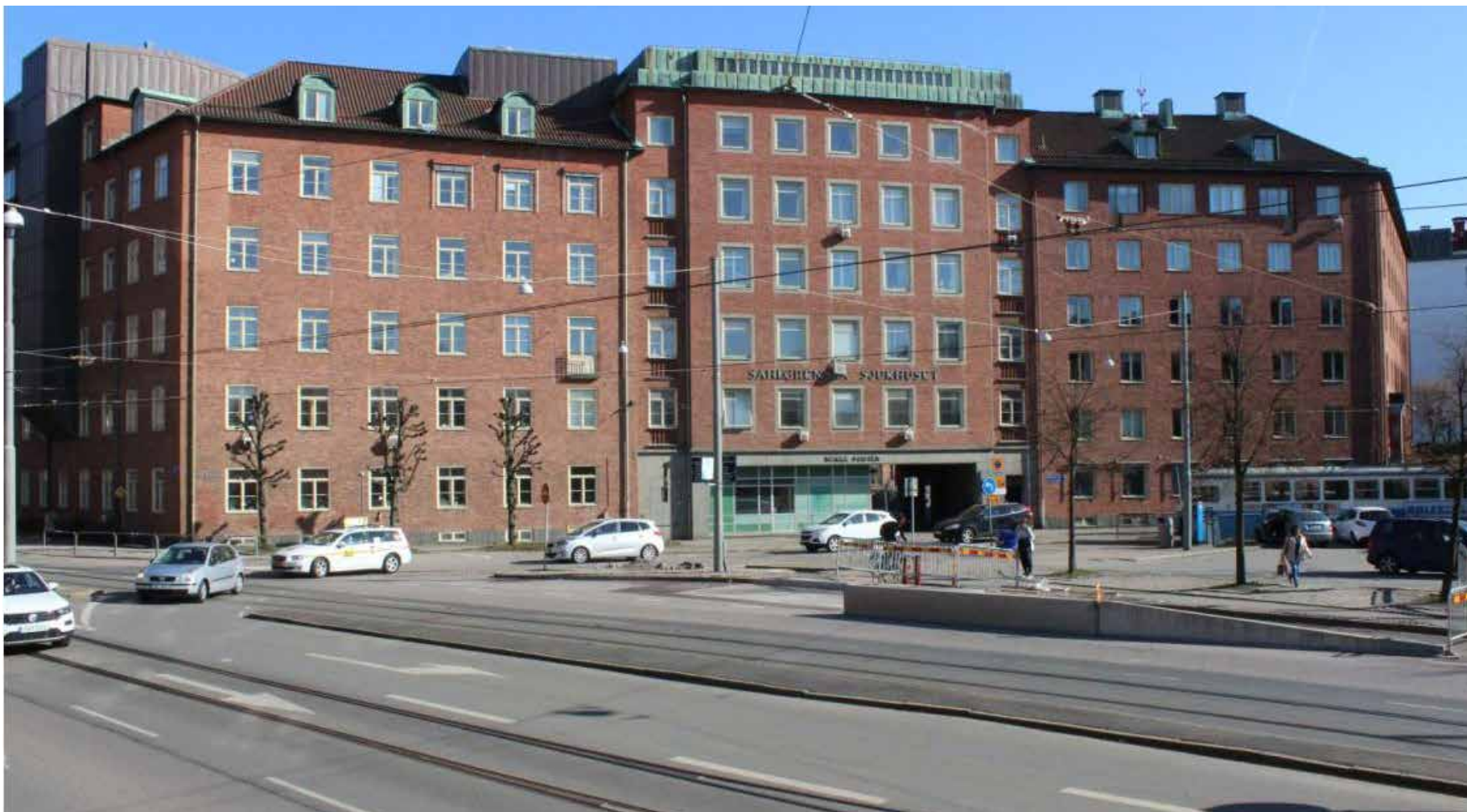
Norra Entrébyggnaden sedd från Nordväst.
