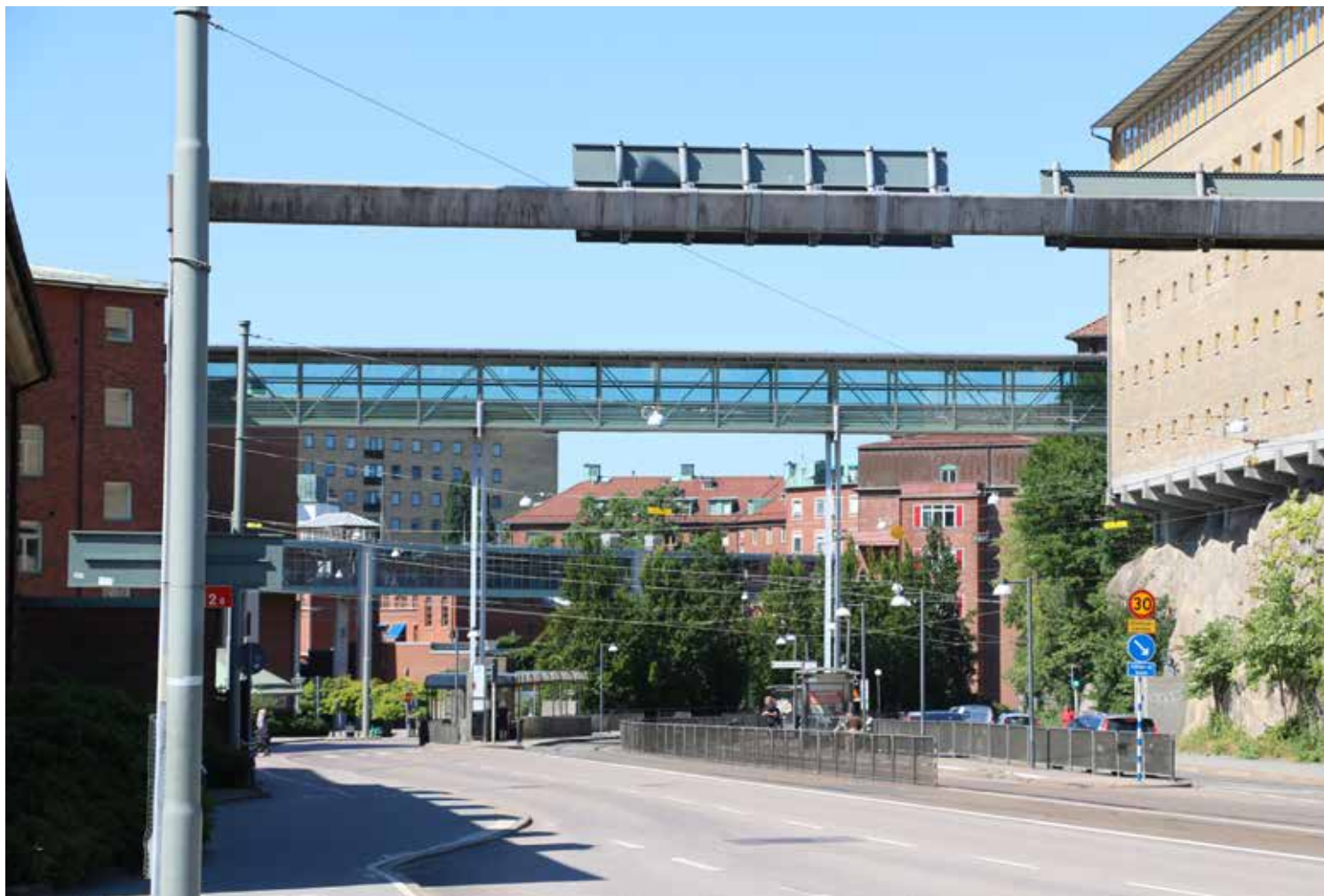
VY 5 Per Dubbsgatan omges av en tät och brokig bebyggelsemiljö. Byggnader som Per Dubbshuset, akuten, ögon- och öronkliniken, universitetsbiblioteket och jubileumskliniken har samtliga individuellt arkitektoniska och miljöskapande värden samtidigt som de sammantaget visar på områdets utveckling under 1900-talet.
