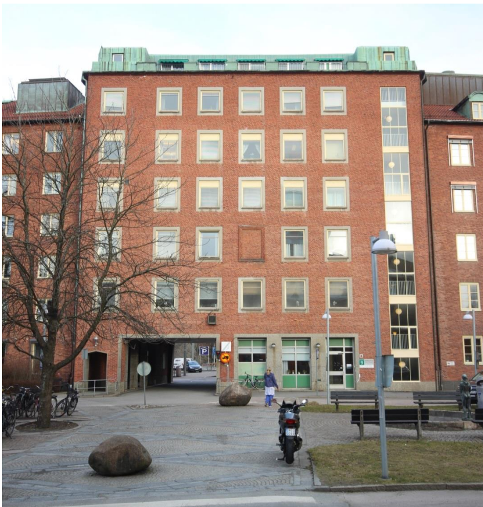
Byggnadens exteriör har genomgått mindre förändringar men är till övervägande del i originalutförande.
