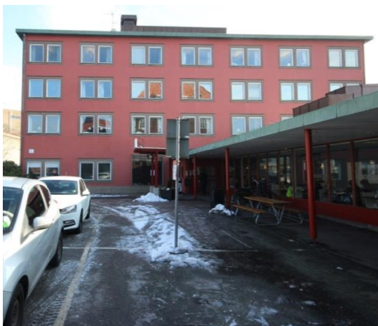
Norra och västra fasaden.
