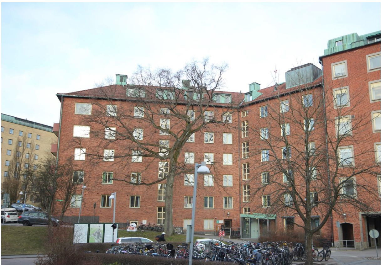
Byggnadens exteriör har genomgått mindre förändringar men är till övervägande del i originalutförande.
