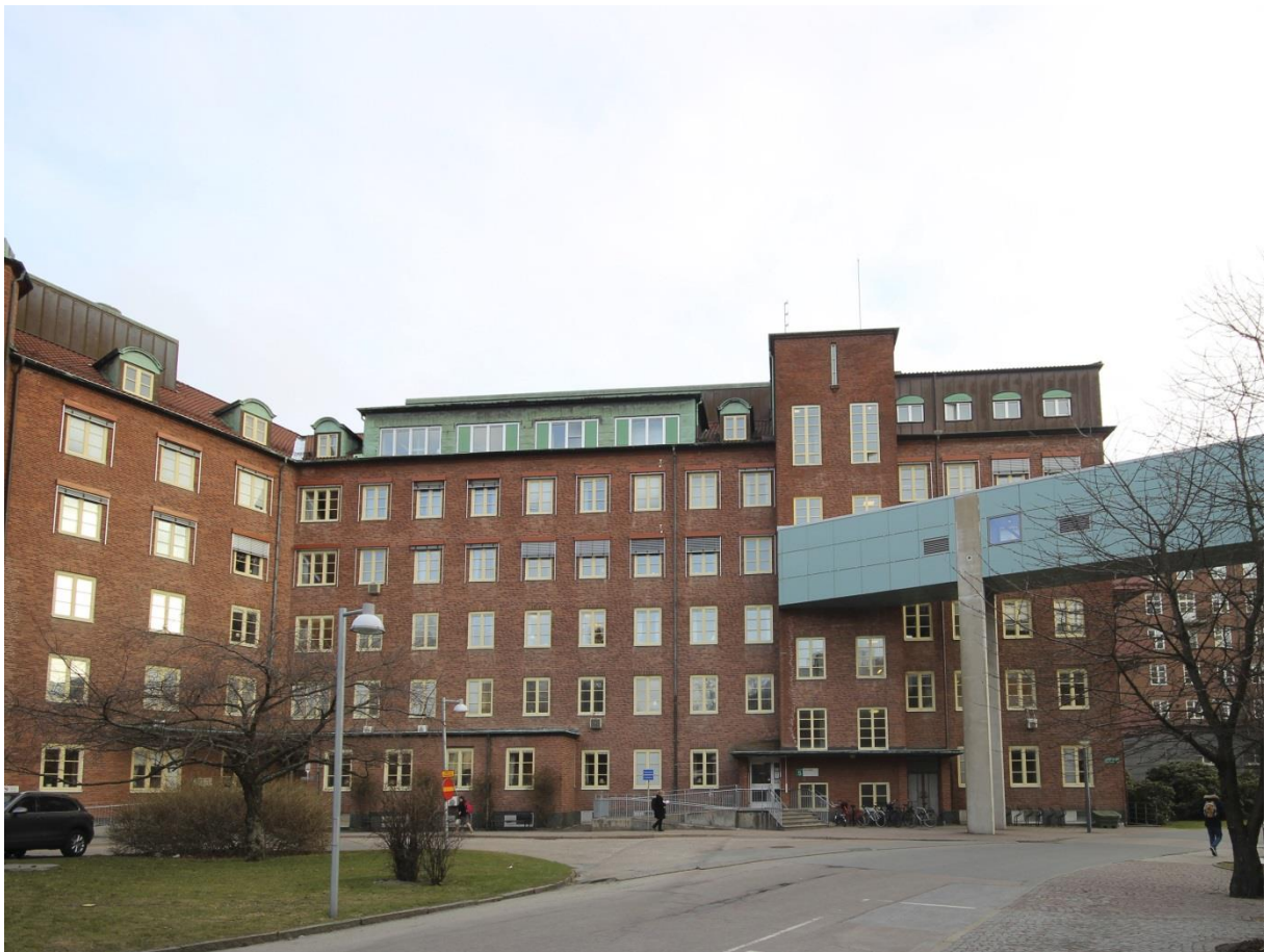
Byggnadens exteriör har byggts delvis byggts om men är till större del i originalutförande.
