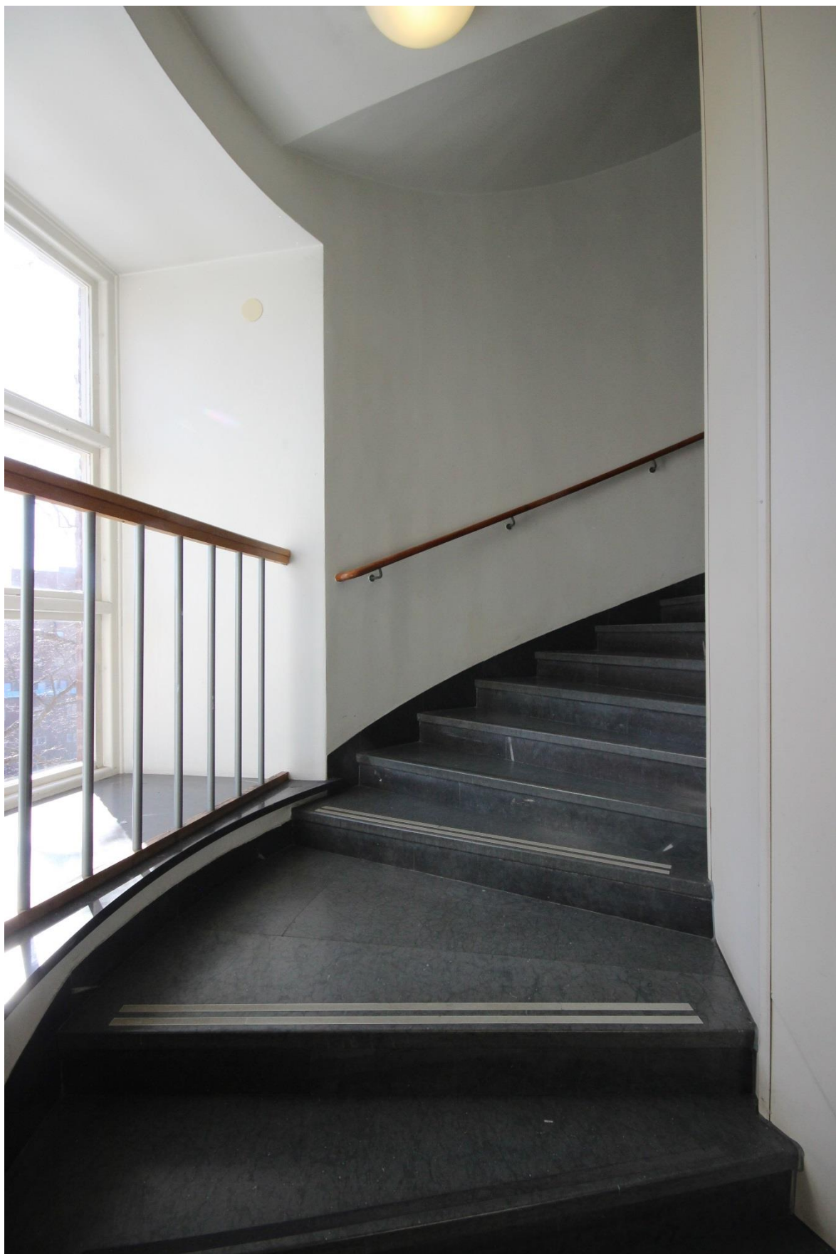
Trapphus mot öster.
