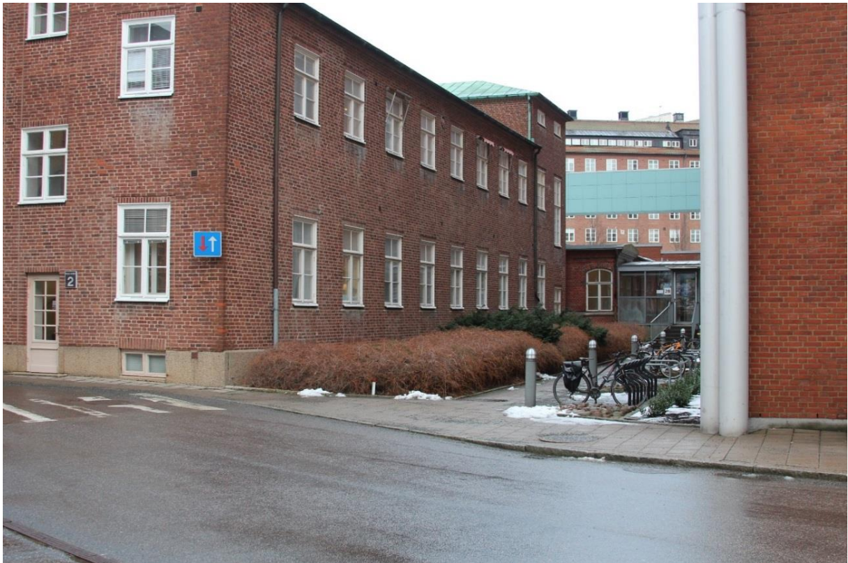
Sydöstra fasaden samt del av gavelfasad mot sydväst.
