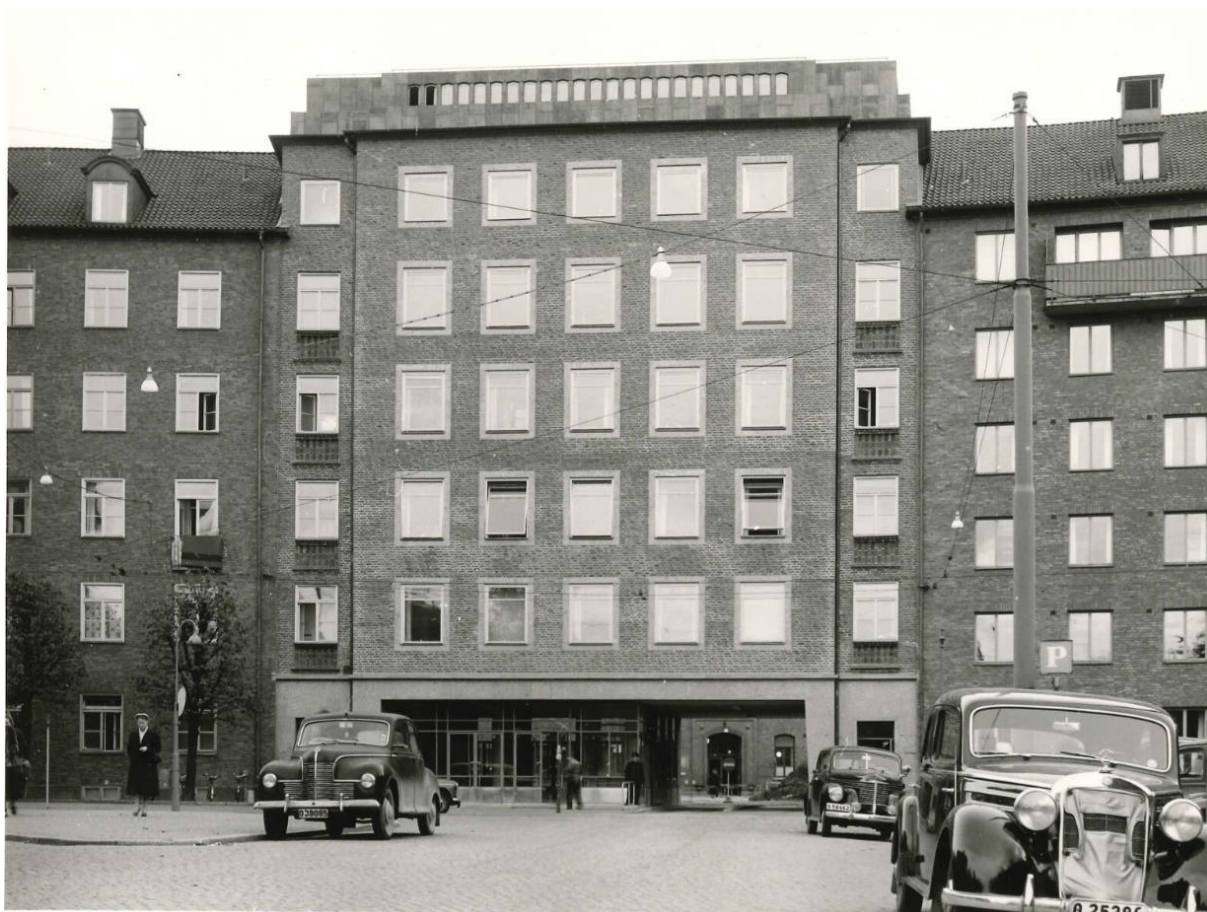
Ögon- och öronklinikens tillbyggnad som uppfördes i öppningen mellan kliniken och sjuksköterskebyggnaden. Fotografi från 1955. (Medicinhistoriska museet)
