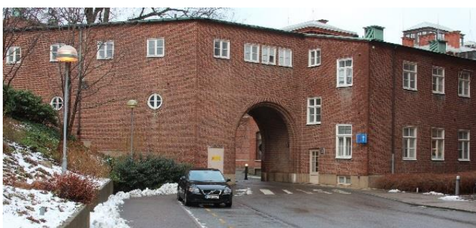
Byggnad 5129 med länkbyggnad 5154.
