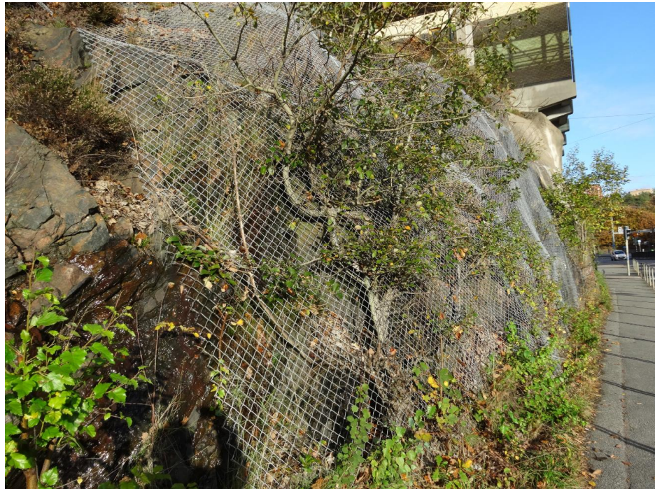
Bild 14 tagen mot öster på bergskärning intill Per Dubbsgatan som förstärkts med nät och sprutbetong längre bort. Inom vissa partier rinner dagvatten ner från berget.
