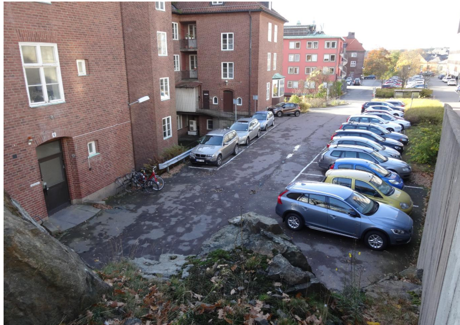
Bild 10 tagen mot väster med Medicinaregatan till höger som ligger på högre nivå än gatan och parkeringsplatser närmast husen till vänster. Nivåskillnaden har delvis tagits upp med hjälp av betongmur och bergskärningar.
