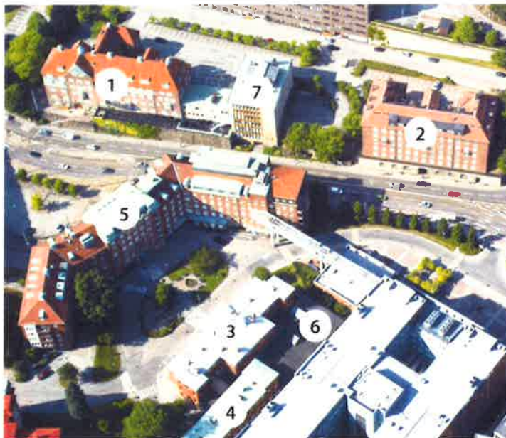
Figur 6. Vy över aktuellt område med de kulturhistoriska byggnader som berörs inom planområdet. Vanförestalten (1), Ortopediska kliniken (2), Per Dubbshuset (3), Tillbyggnaden på Per Dubbshuset (4), Öron- och ögon/Bostäder för sköterskor, Tillbyggnad entré (5), Per Dubbshusets tillbyggnad (6) och Vanförestaltens tillbyggnad (7). Bild: KMV Forum.
