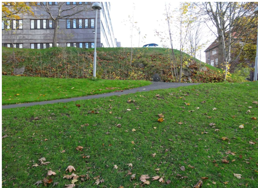
Bild 9 tagen mot öster på hög slänt och gata och sydvästra hörnet på Odontologen. Sannolikt har grövre massor av krossmaterial påförts det yliga berget för att skapa plats intill byggnaderna.
