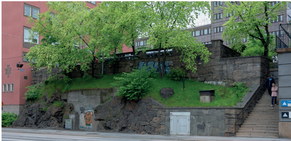
Bild på befintligt murverk mot Per Dubbsgatan
