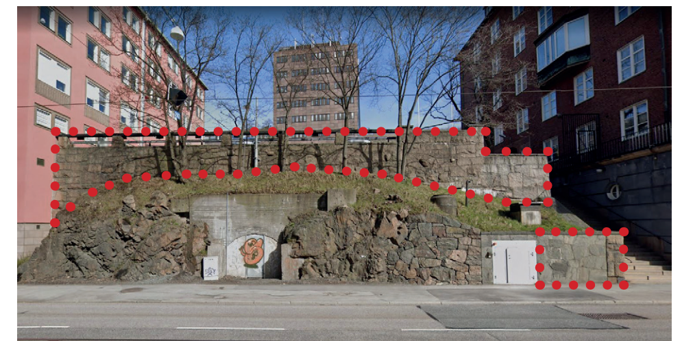
Bild på den befintliga muren
