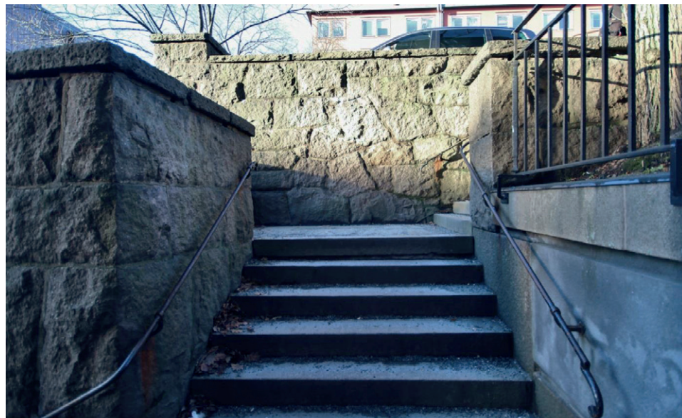
Bild på befintliga murpartier längs Victor Bensowstrappa
