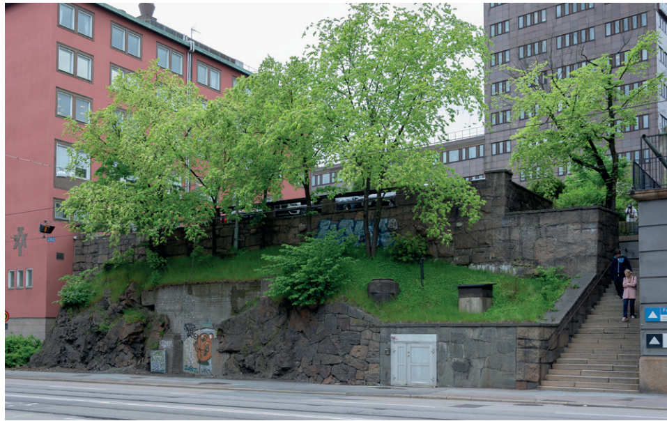
Bild på befintlig mur
