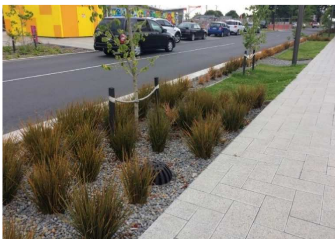
Figur . Exempel på makadamdike som täckts med växter och gräs.
