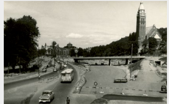
Dag Hammarsköldsleden byggs. Foto: Hjalmar Wijk, 1961.
