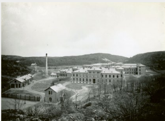
Sahlgrenska sjukhuset, Barnsjukhuset och Epidemisjukhuset byggdes enligt paviljongsystemet, med friliggande eller sammanlänkade paviljonger.
