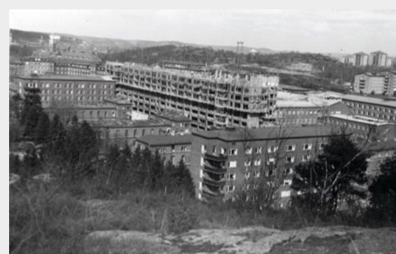
Uppförandet av centralkomplexet på Sahlgrenska pågick under flera års tid. Foto: Hjalmar Wijk, 1956.
