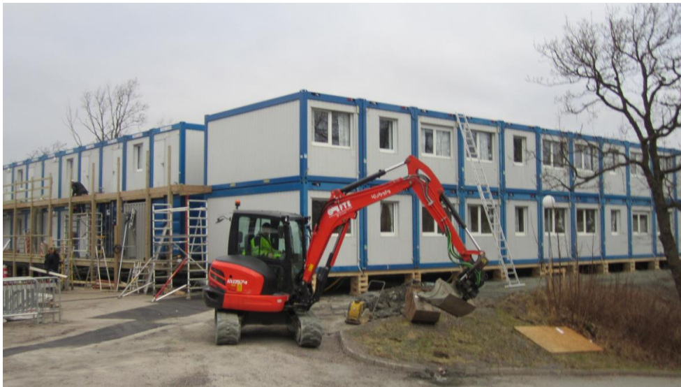
Bild 10. Installation av moduler i delområde 2. Vy från infarten vid Medicinaregatan.
