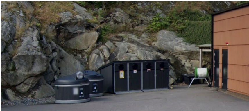
Figur 5 – Befintliga avfallsskåp och markbehållare/moloker vid Primohuset
