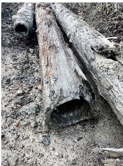
Figur 1 Vid ett ledningsarbete i Södra vägen 2023 hittades dessa äldre trärör som ledde vatten från Kallebäckens källa till Kungssportsplatsen. "Det (rören) är ett fantastiskt hantverk. Man ser fortfarande spik- och muffände och rören har legat väl bevarade i syrefattig lera på ungefär två meters djup. Här har leran varit en positiv tillgång för en gång skull", säger Eva Hansson, projektledare för arbetet som gjorde att rören hittades.
