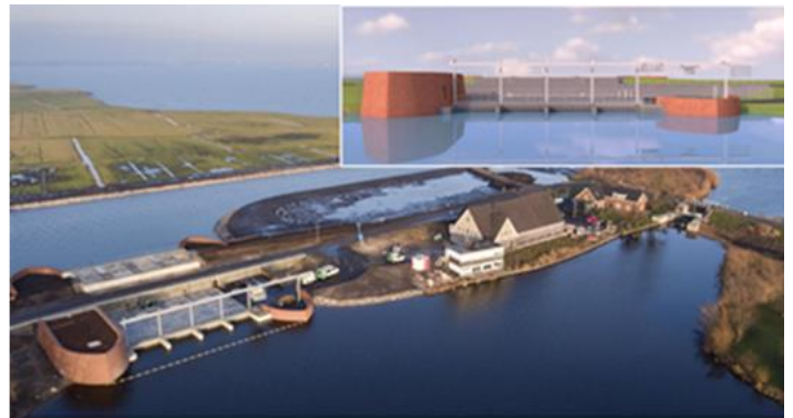
Figur 5. Exempel på äldre modell av pumpstation t.v. (A.F. Stroink) samt nyare skyddsport och pumpstation i nederländska Schardam med kapacitet på 2000 m 3 /min (där Sweco utformat pumpstationen).
