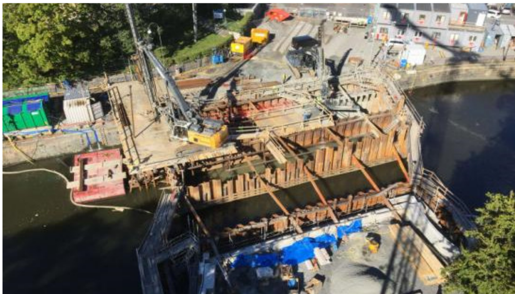
Bild: Återuppbyggnad av Vasabron, Foto: Trafikkontoret, Göteborgs Stad
