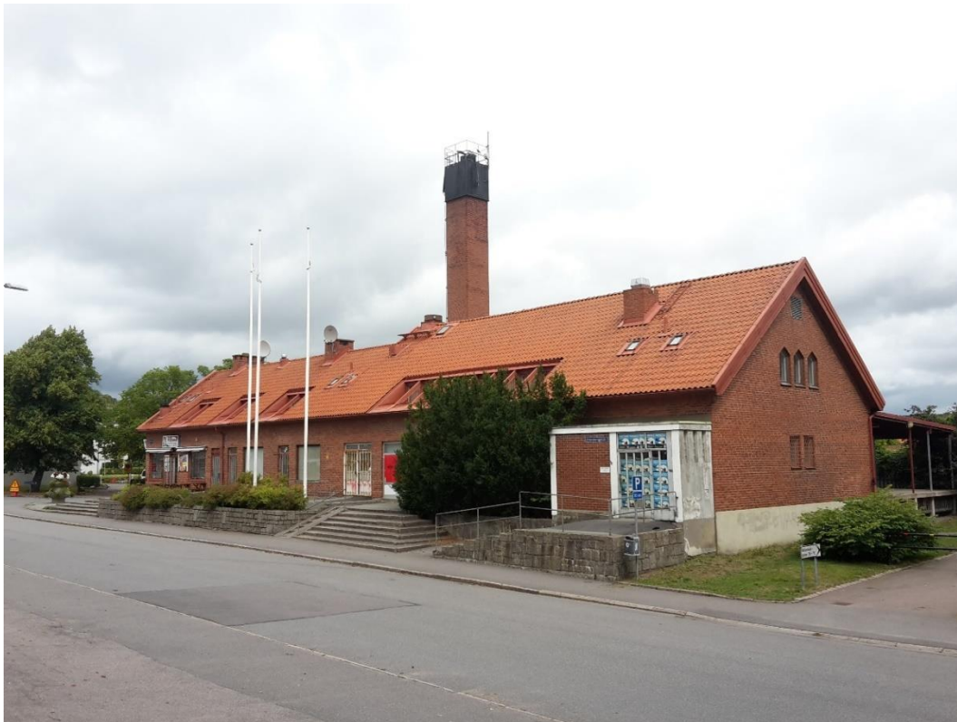
Figur 2. Foto: Den befintliga butikslängan och före detta panncentralen
