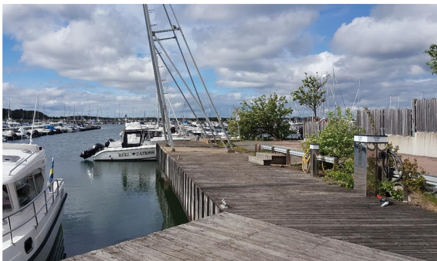
Figur 6 Kaj på området västra sida.
