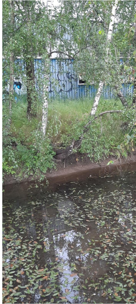
Figur 8 Tecken på erosions med lutande träd längs västra sidan av bäcken, ungefär i höjd med norra satellitområdet för Backaplan DP2.
