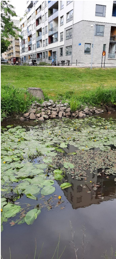
Figur 1 Befintligt erosionsskydd på västra sidan i höjd med Borstbindaregatan.
